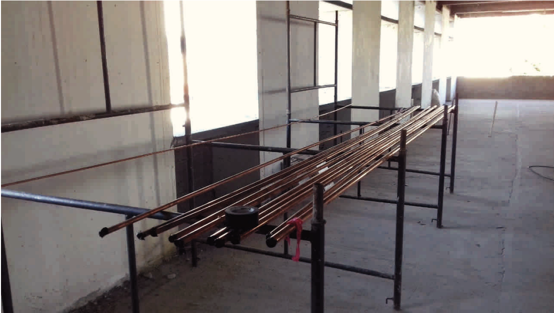
Foto 1: Tubulação da climatização
