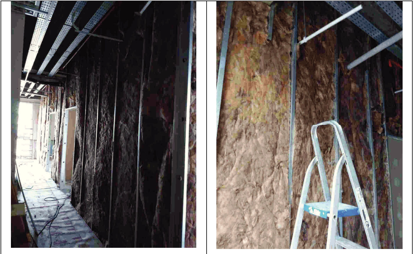
Figura 3: Instalação das paredes de gesso com isolamento acústico de lã nos três pavimentos.
