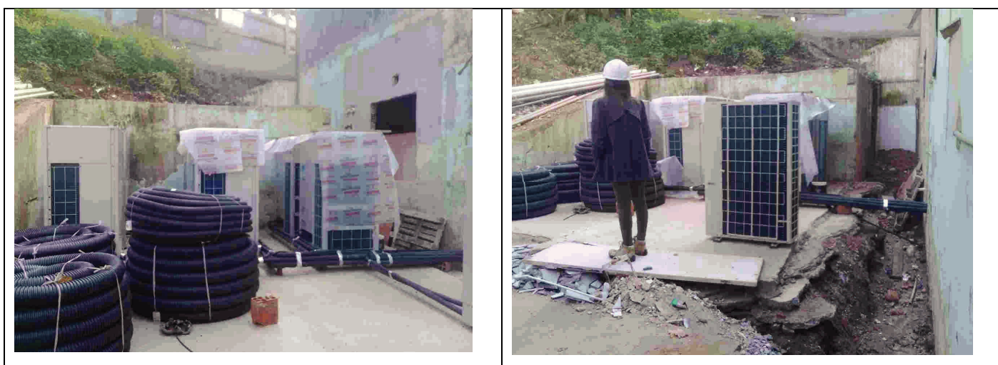
Figura 5: Instalação condensadores.
