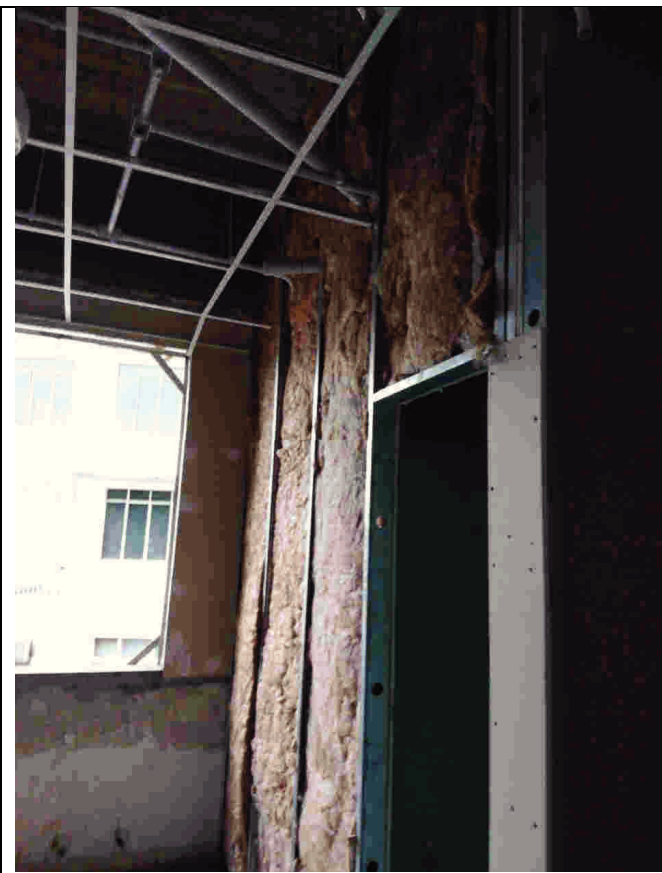
Figura 2: Instalação das paredes de gesso pavimento térreo.
