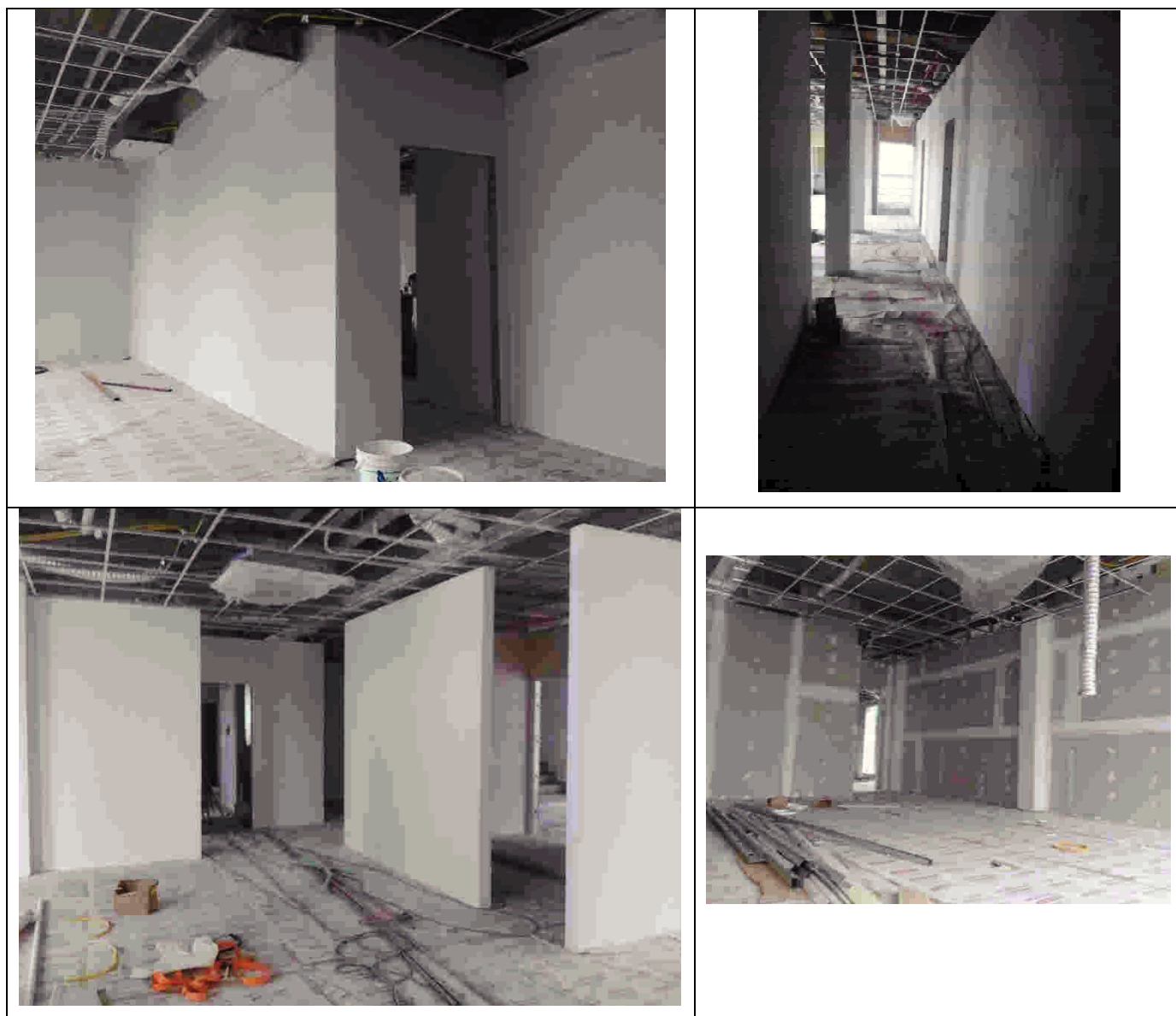
Figura 1: Instalação das paredes de gesso com isolamento acústico de lã e acabamento com pintura do 2º e 3º pavimento.
