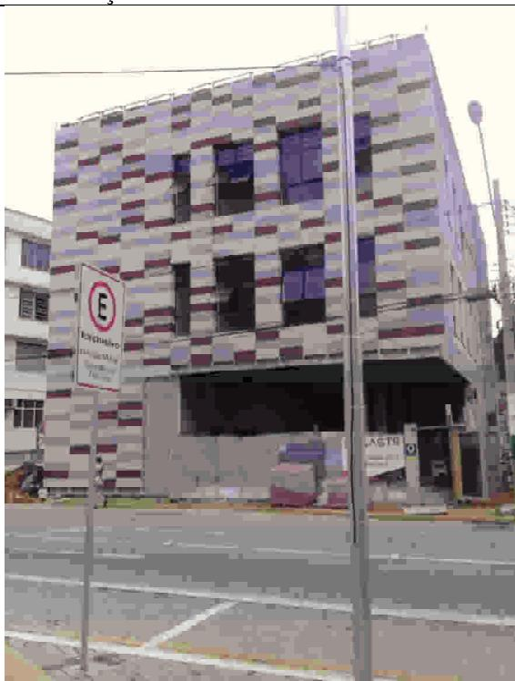
Na Figura 1, finalização da instalação da fachada ventilada em ACM.
