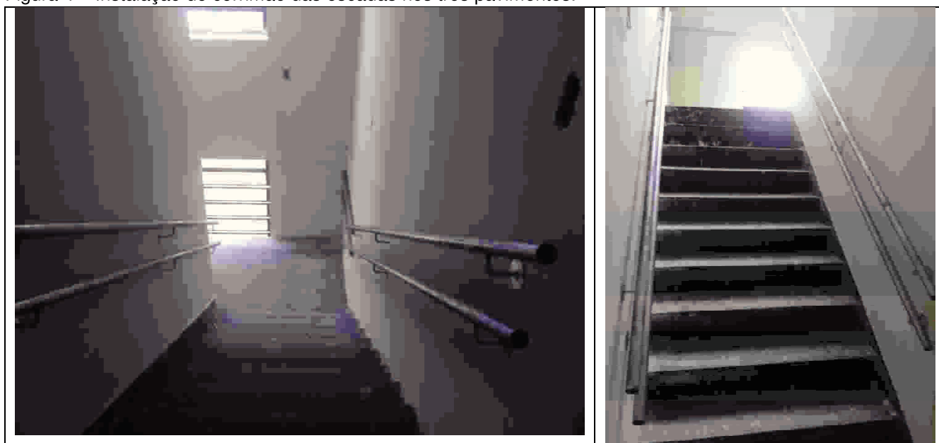
Figura 4 – Instalação de corrimão das escadas nos três pavimentos.
