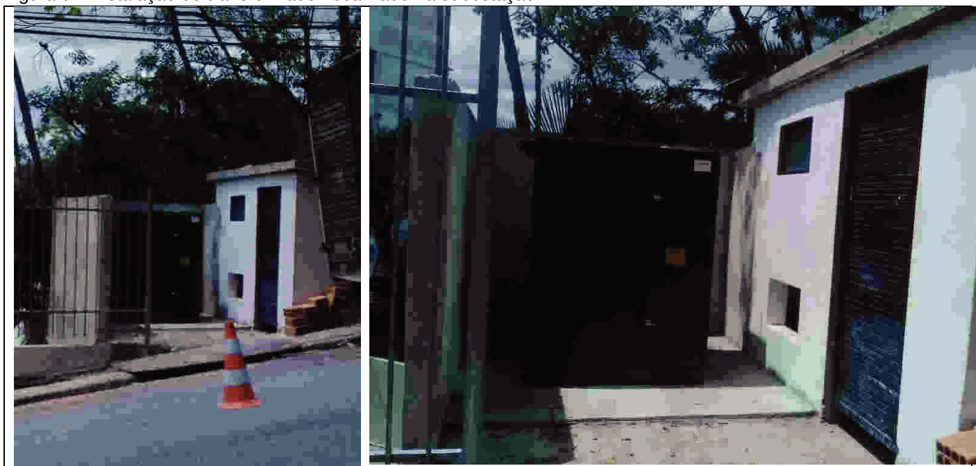
Figura 9 – Instalação do transformador localizado na subestação.
