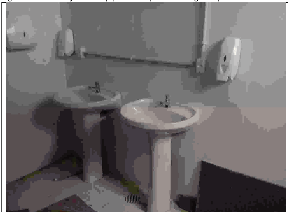
Figura 11 – Instalação dos equipamentos primeiro e segundo pavimento.
