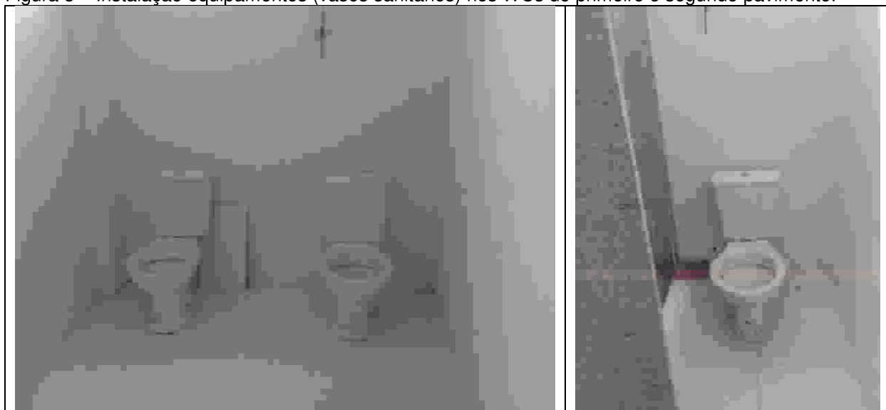
Figura 3 – Instalação equipamentos (vasos sanitários) nos WCs do primeiro e segundo pavimento.
