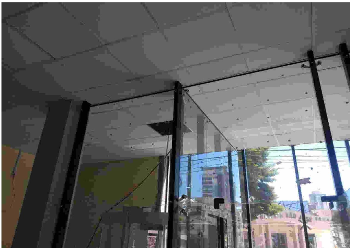
Figura 7 – Conclusão Forro Mineral.
