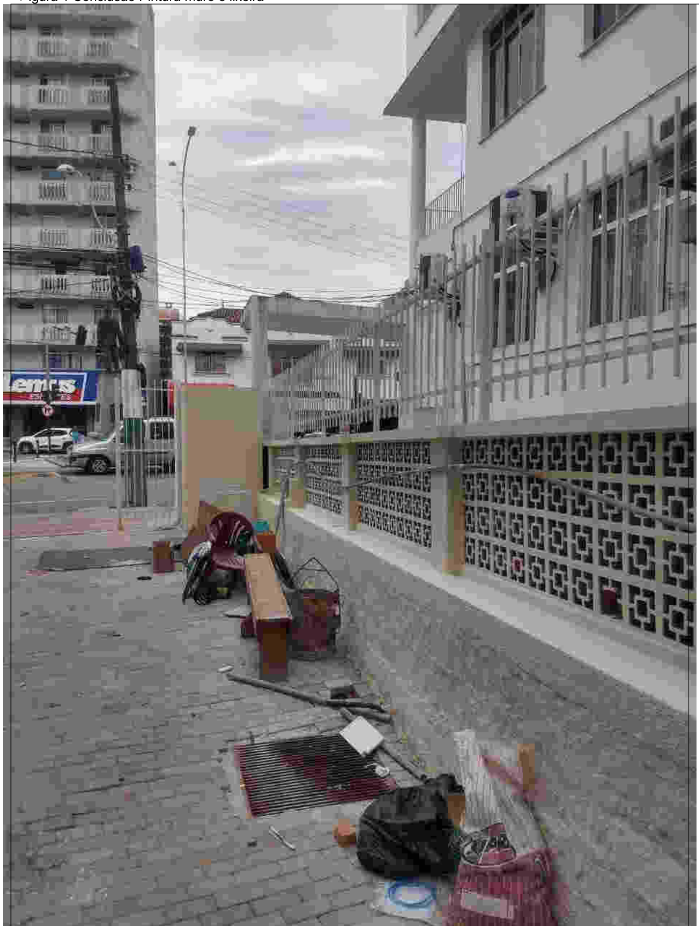
Figura 1 Conclusão Pintura muro e lixeira
