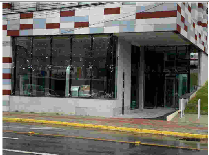
Detalhe do acesso principal
