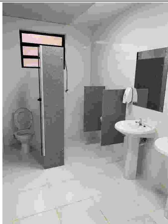
WC com divisórias instaladas
