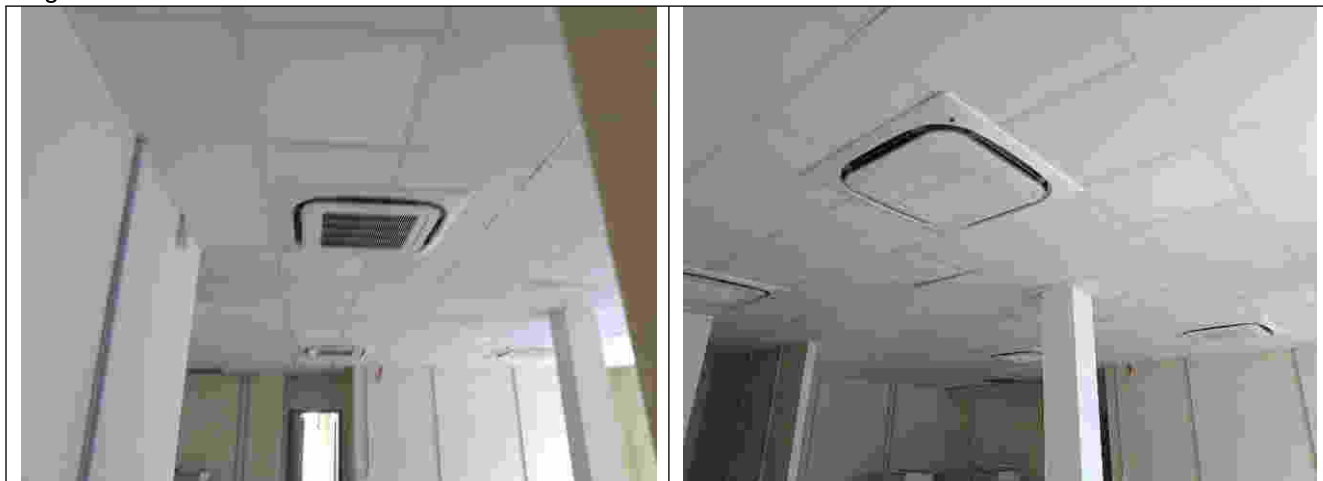
Figura 4 – Conclusão Forro mineral.
