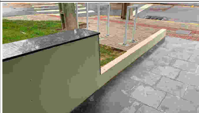
Detalhe da mureta lateral
