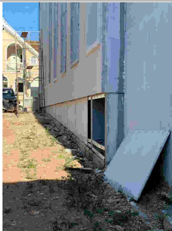
Detalhes dos acabamentos e meio fio na fachada lateral - Eng. Victor solicita solução para o acabamento e remoção do meio fio.
