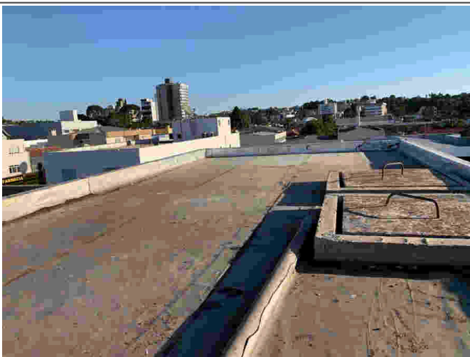
Cobertura - laje do reservatório
