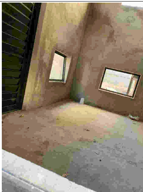
Vista interna abrigo medidores
