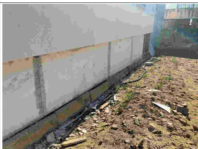
Detalhe do meio fio e acabamentos na fachada lateral
