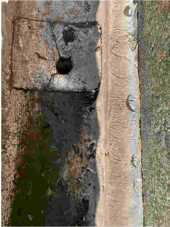
Detalhe de calha da cobertura
