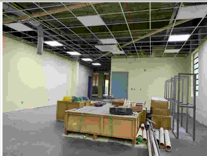
Vista da secretaria no térreo e equipamentos do elevador
