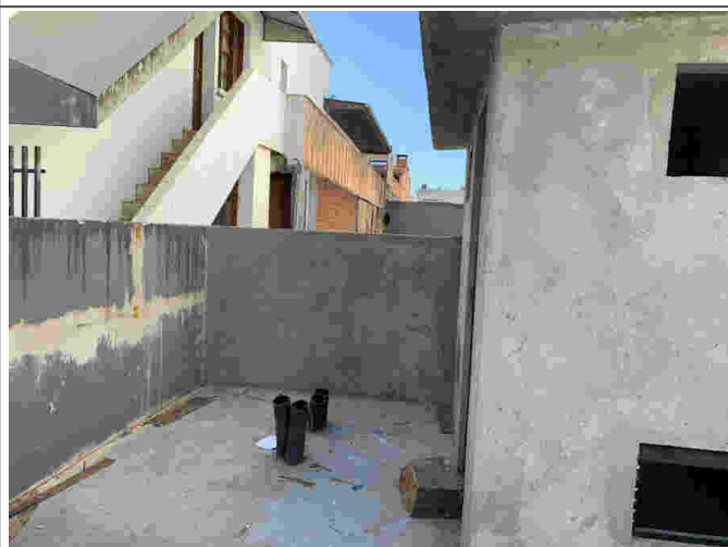
Local para o transformador
