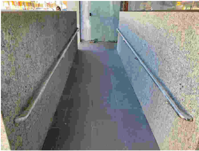
Corrimão inox externo na rampa de acesso
