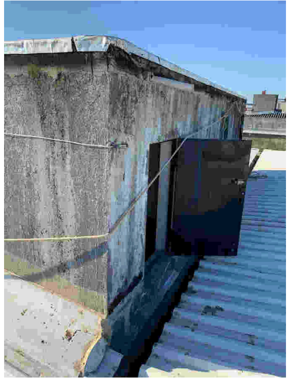
Detalhe da porta de acesso a cobertura
