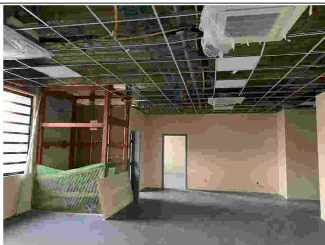
Hall do andar superior (estrutura da caixa do elevador) e acesso a sala de audiências
