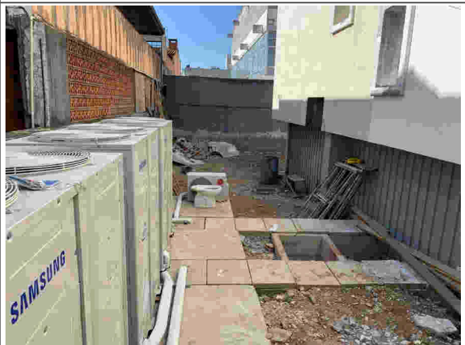
Espaço dos fundos com as condensadoras de A/C
