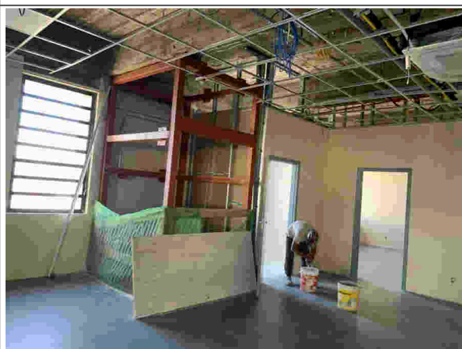
Vista da caixa do elevador
