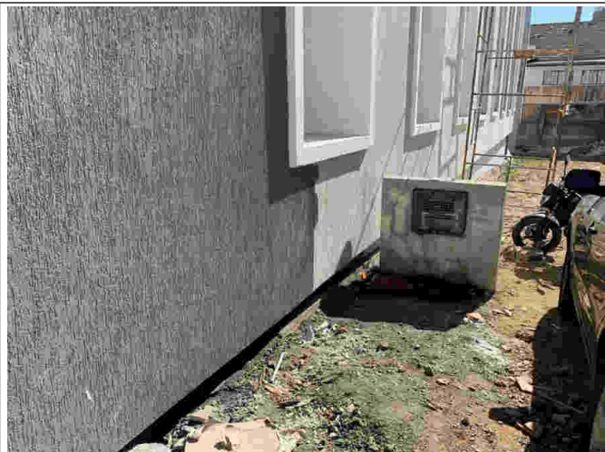
Local do medidor de água e portão
