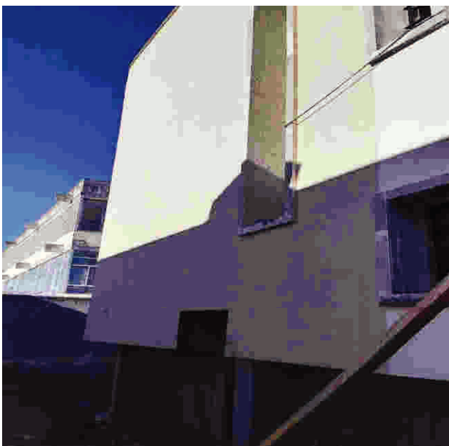
ADITIVO 3 -Item 5.4- Aplicação de tinta acrílica fosco completo premium - 3 Demãos
