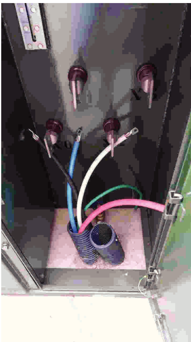
Passagem de Cabos 95mm e 50mm
