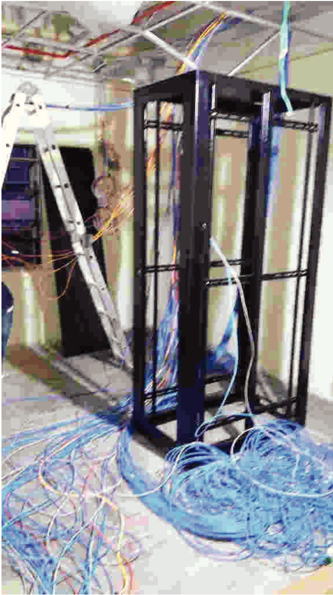
Passagem dos cabeamento de lógica e interligação no Rack
