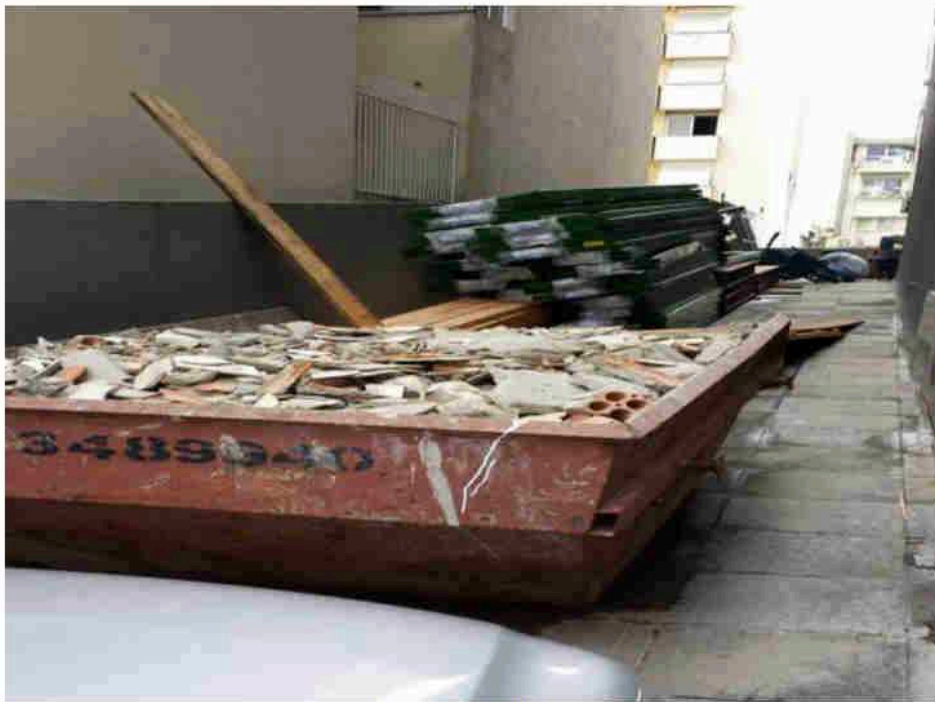
Retirada de entulhos 14/03/2014 - Condicionadores de ar
