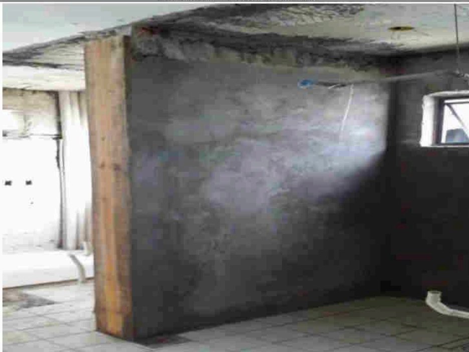
Reboco do banheiro 04/04/2014 - Estrutura de madeira
