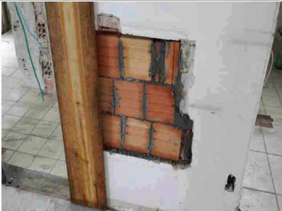
Fechamento em alvenaria da parede onde existia gás. 02/04/2014 - Bandeja de proteção
