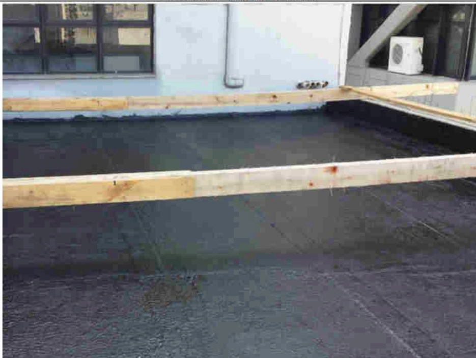
Impermeabilização da laje da cobertura 08/04/2014 - Estrutura para tela de polipropileno
