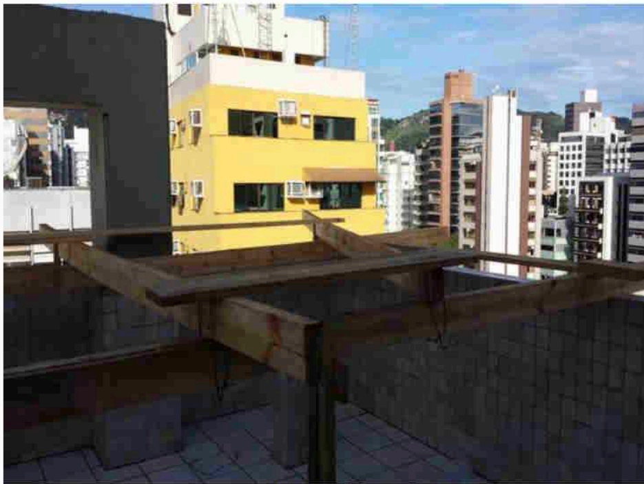
Estrutura de madeira para tela de polipropileno. 08/04/2014 - Impermeabilização da laje
