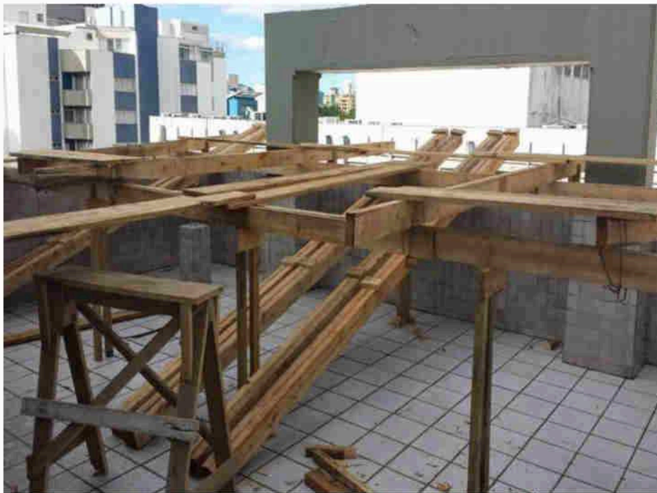
Montagem de estrutura de madeira para suporte da tela e do jáu. 07/04/2014 - Impermeabilização
