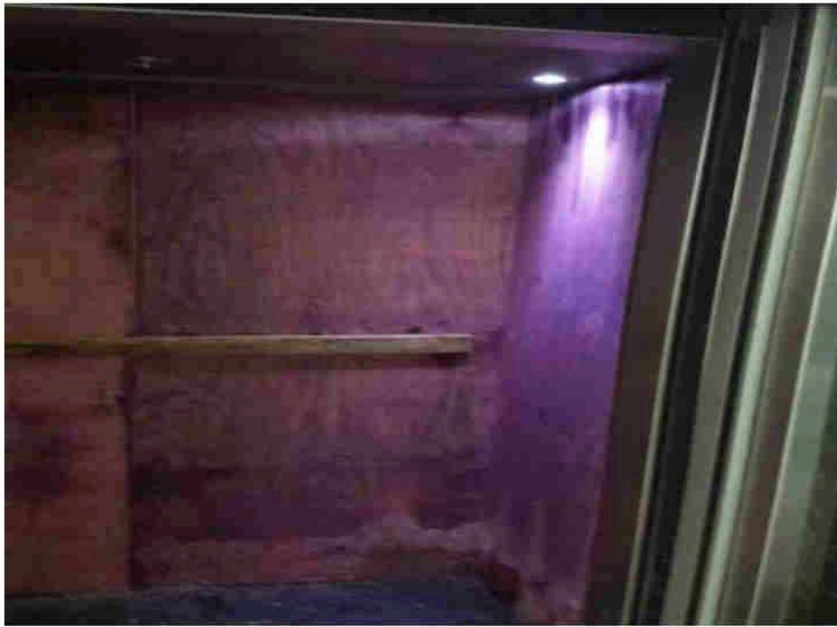
Instalação de uma proteção para o elevador.
