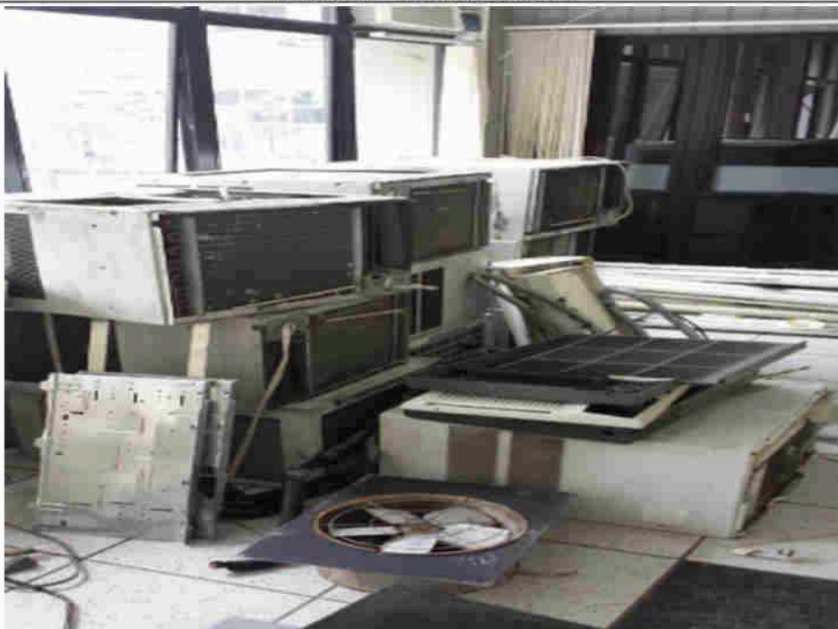
Condicionadores de ar 21/03/2014 - Descida dos condicionadores de ar
