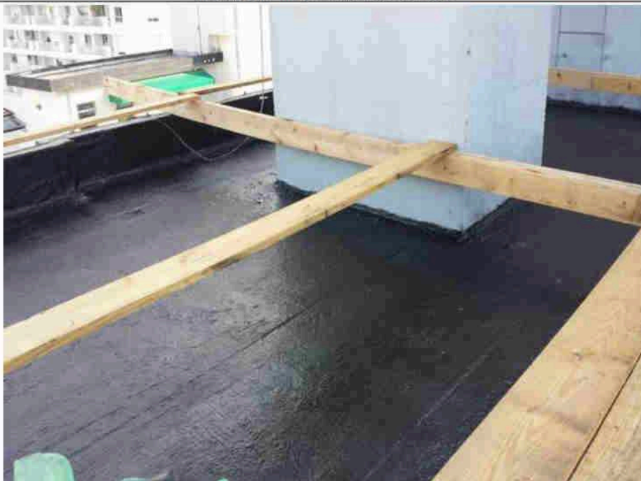
Impermeabilização da laje de cobertura. 10/04/2014 - Bandeja
