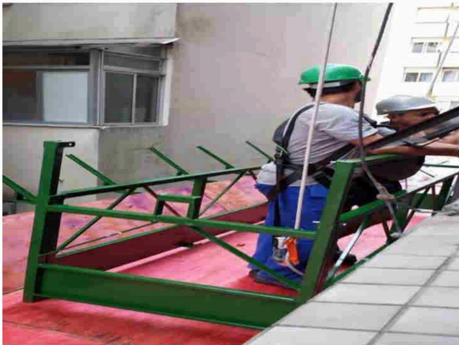
Montagem do Jaú 22/04/2014 - Reboco teto WC
