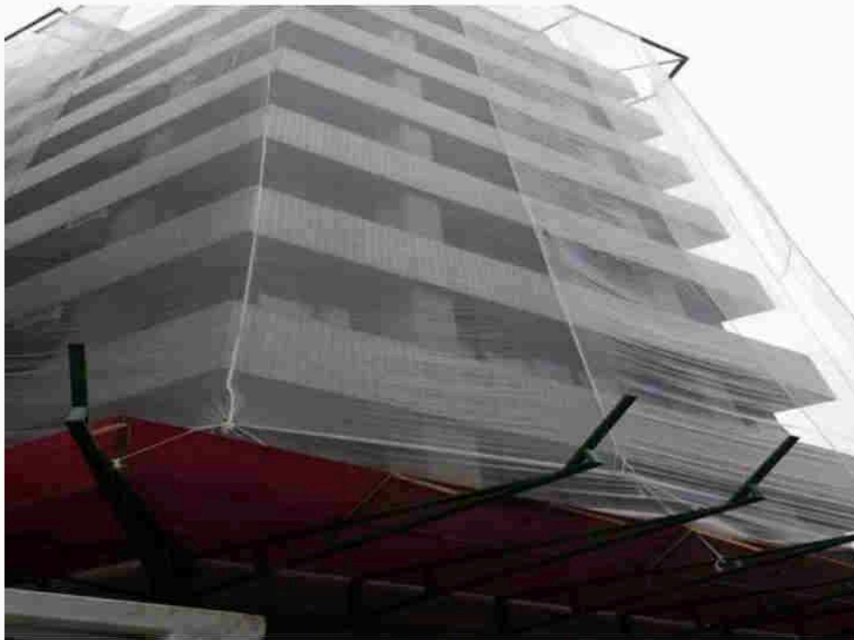
Tela de proteção instalada na fachada. 23/04/2014 - Troca de local da porta
