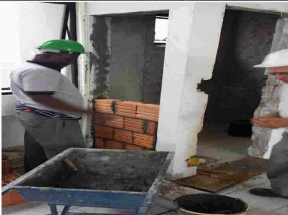
Troca de local da porta 23/04/2014 - Escariação da fachada
