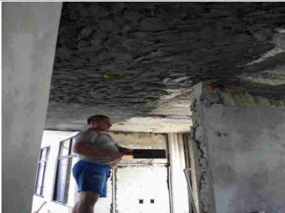
Reboco teto WC 23/04/2014 - Tela de polipropileno
