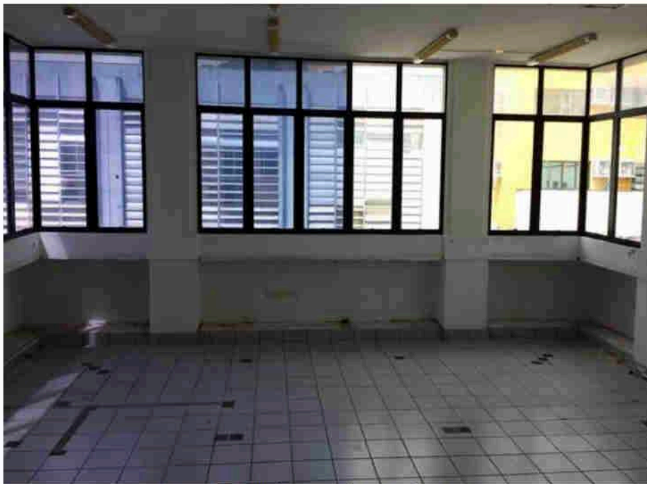
Retirada de divisórias e armários do sétimo andar. 21/02/2014 - Retirada de divisórias e armários
