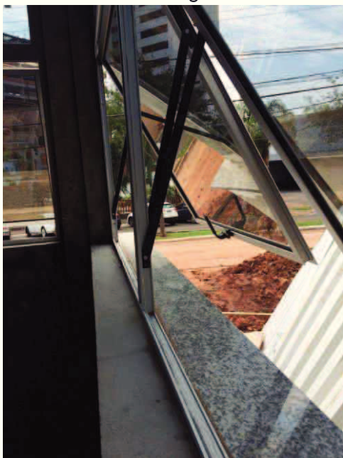
Imagem pavimento térreo
