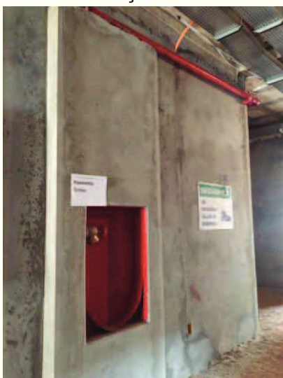
Imagem pavimento térreo
