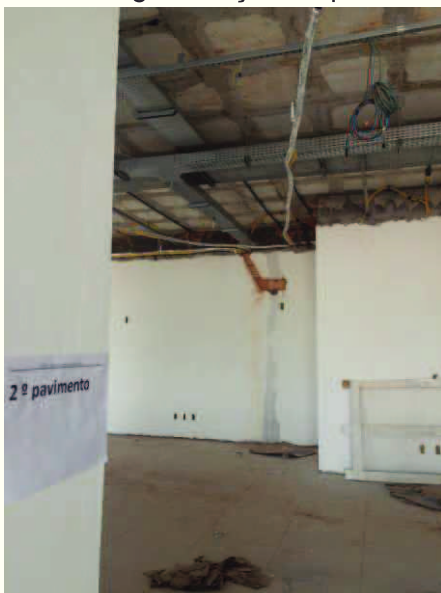
Imagem regularização primeiro pavimento
