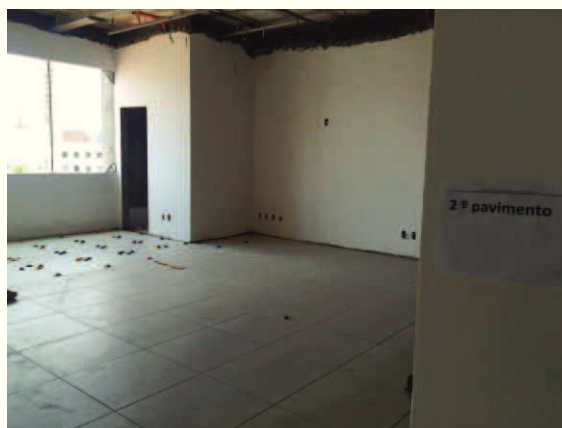
Imagem porcelanato terceiro pavimento
