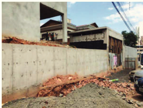
Imagem muro de contenção
