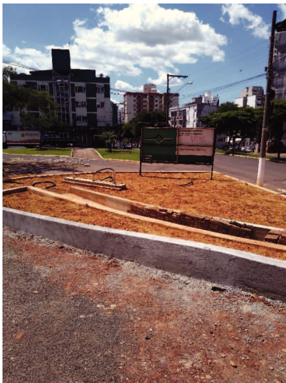
(Imagem mastros concretados)
