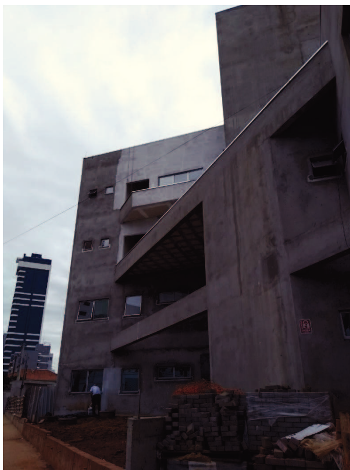
(Imagem Fachada 01 – Forros Sacadas)
