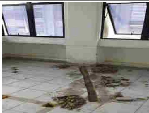
Corte em piso para passagem de tubulação
