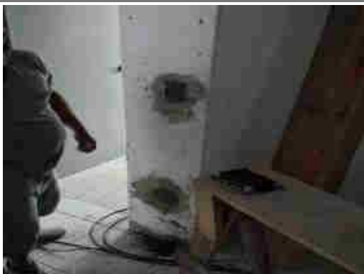
Fechamento de pontos elétricos
