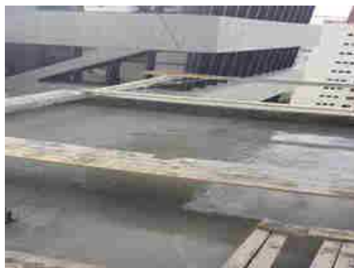
Regularização com caimento para as extremidades
