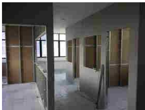
Montagem paredes de gesso
