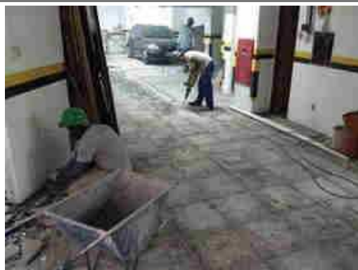
Demolição pedra ardozia e concreto
