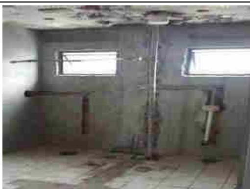
Rasgos em paredes
