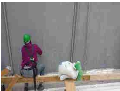
Escariação parede cobertura para conserto de fissuras
