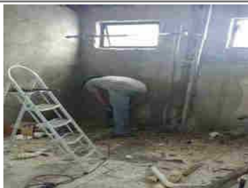
Regularização com caimento para as extremidades
