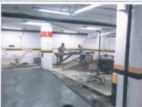
Armadura passarela PNE
