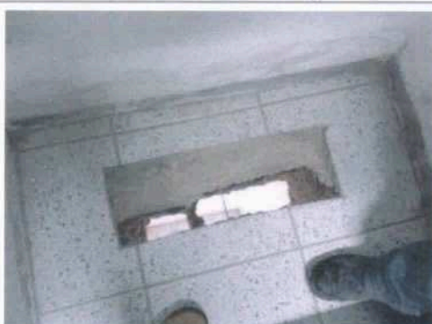
Corte em lajes para passagem de prumada elétrica
