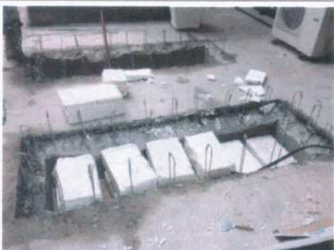
Confecção de laje nervurada
