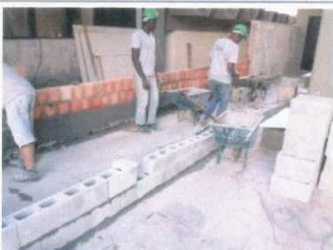
Alvenaria estrutural e mureta extra
