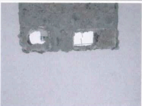
Corte em lajes para passagem da prumada elétrica
