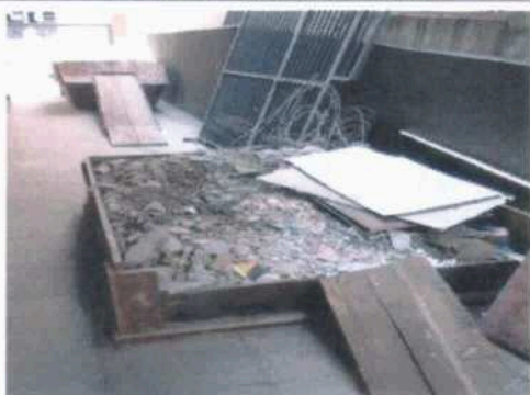
Retirada de entulho
