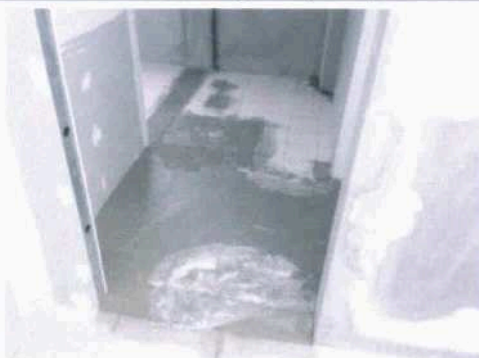
Regularização para receber piso vinílico
