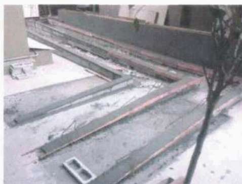
Base e mureta rampa externa
