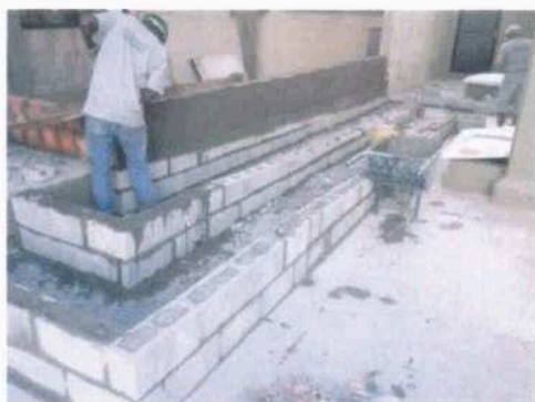
Base e mureta rampa externa
