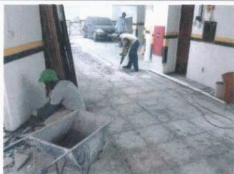
Demolição pedra ardózia e concreto
