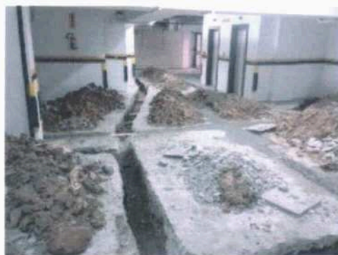
Demolição de concreto para execução da malha de aterramento e tubulação de esgoto.
