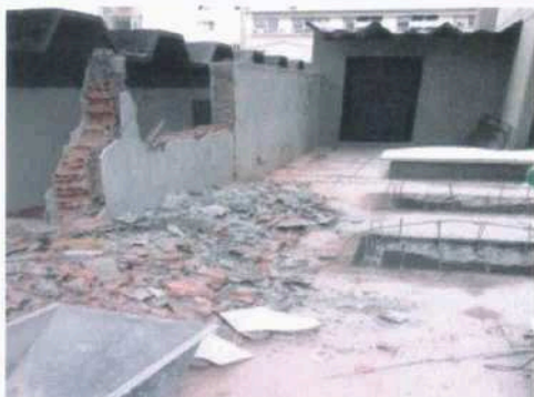
Muro externo demolido
