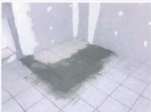
Regularização de piso
