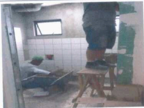
Colocação de azulejo no pvto 5.
