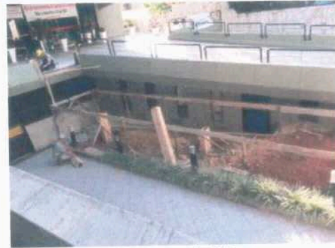
Pilar passarela PNE
