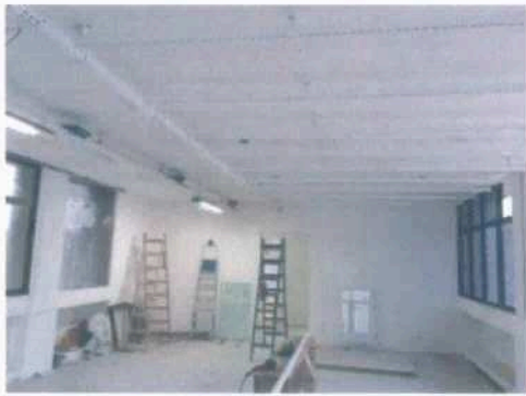
Instalação de perfis metálicos para instalação de luminárias
