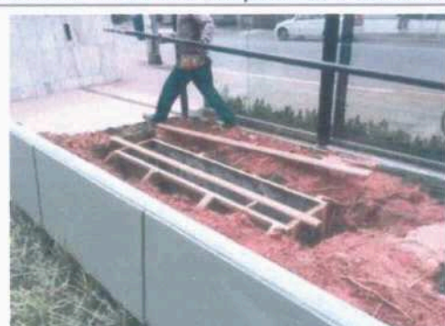
Caixaria de base para mastros das bandeiras
