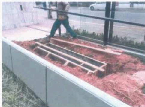
Caixaria para confecção da base que suporta os mastros das bandeiras.
