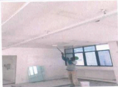
Pintura do teto do 7º andar.
