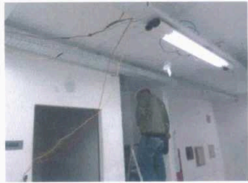
Instalações de eletrocalha no pvto 2
