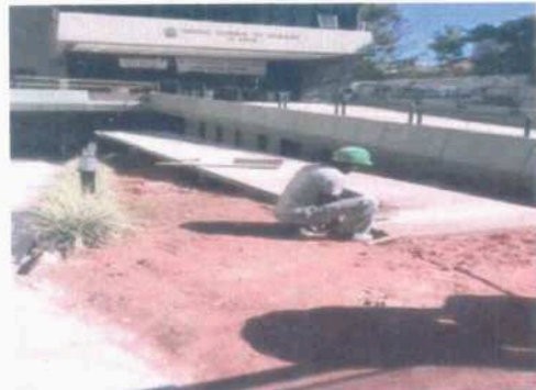
Desforma passarela PNE
