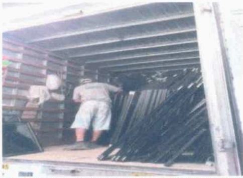
Carregamento das esquadrias retiradas do ático, 7º, 6º, 5º e 4º pavimentos.
