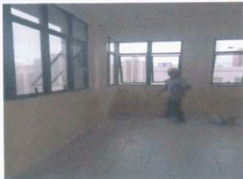
Primeira demão de pintura de paredes com tinta palha
