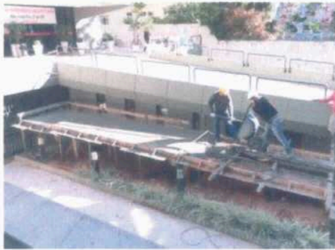
Concretagem da passarela PNE
