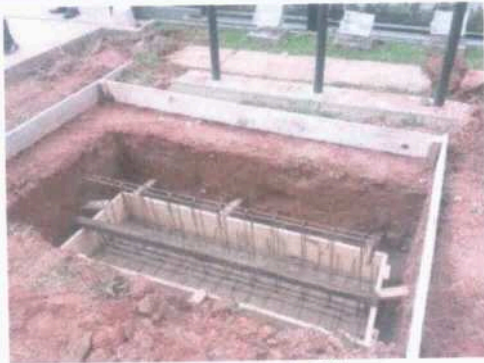
Sapata passarela PNE
