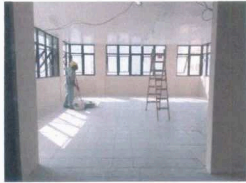
Pintura parede e tetos 6º pavimento
