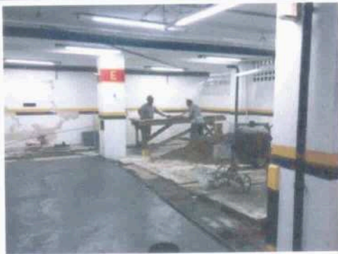
Armadura passarela PNE
