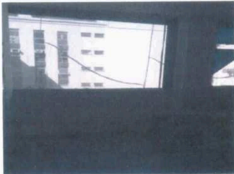
Retirada de esquadrias para instalação das novas janelas
