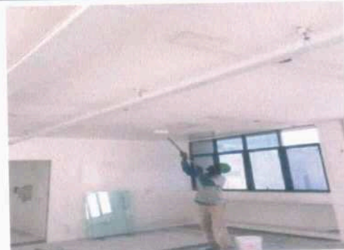
Pintura do teto do 7º andar.
