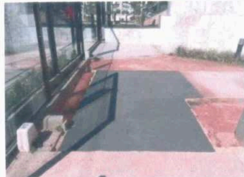
Concretagem calçada passarela PNE
