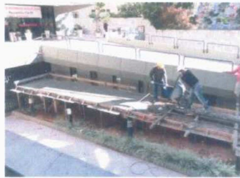
Concretagem da passarela PNE.
