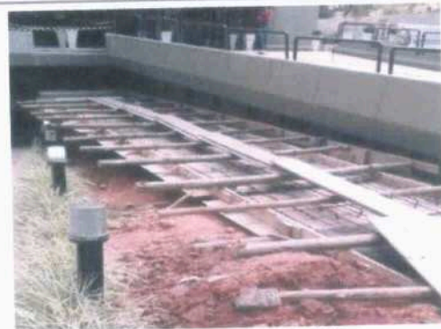
Estrutura da passarela PNE
