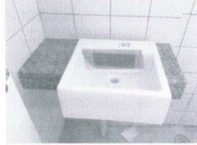
Instalação de bancadas de granito e cubas nos bwc's
