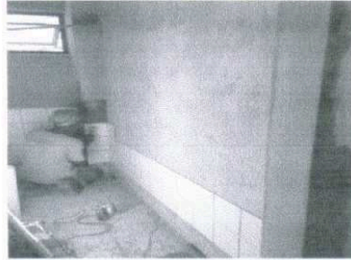
Colocação de azulejo vestiário masculino térreo
