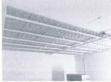
Instalação de manta Sonex estúdio 7º pavimento
