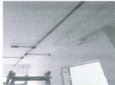
Instalação de eletrocalhas 5º pavimento
