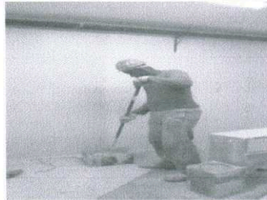
Pintura pavimento subsolo
