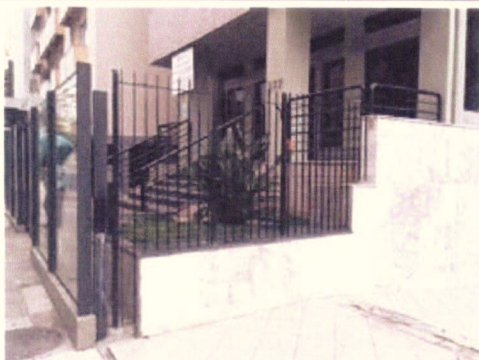
Instalação de grades
