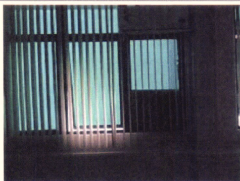
Instalação de persianas
