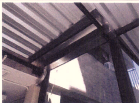
Instalações rufos e calhas
