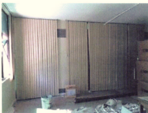
Instalação de persianas
