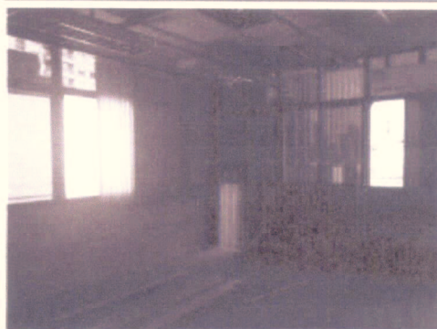
Instalação de persianas
