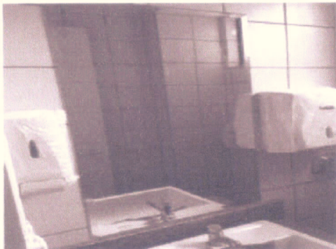
Instalação de espelhos
