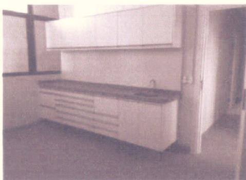
Instalação de torneira com acionamento através de pedal nos consultórios odontológicos
