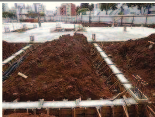
Laje concretada
