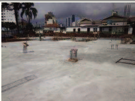
Laje concretada
