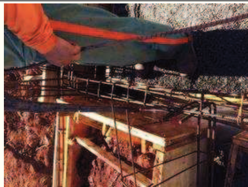
Limpeza dos arranques dos pilares e caixarias.
