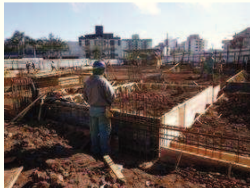
Montagem de armaduras
