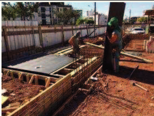
Caixaria Laje maciça
