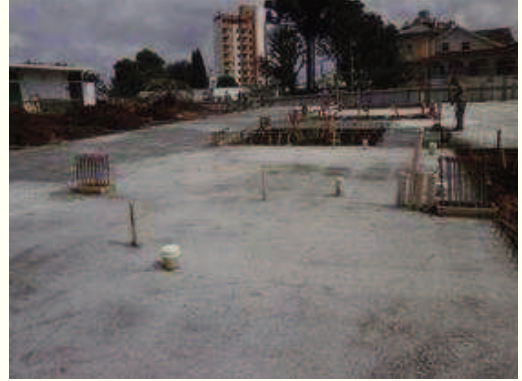
Laje concretada
