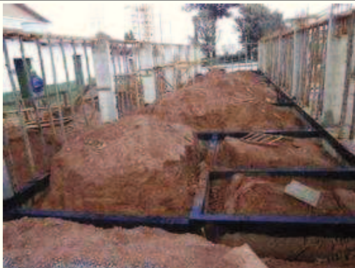
Vigas de baldrame
