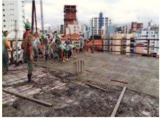
Concretagem da laje do terceiro pavimento.
