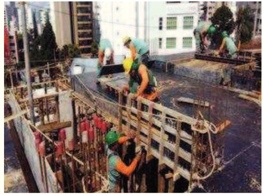
Colocação dos painéis externos das vigas.
