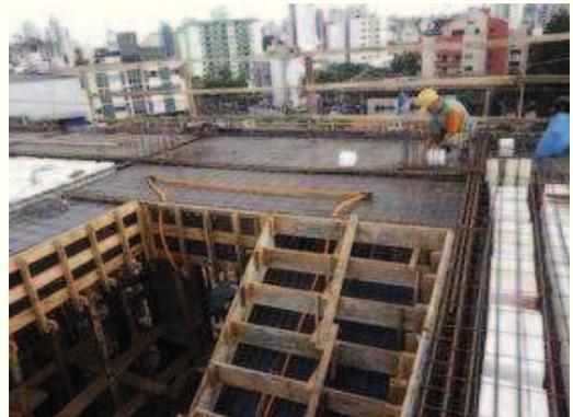
Instalação elétrica da laje.
