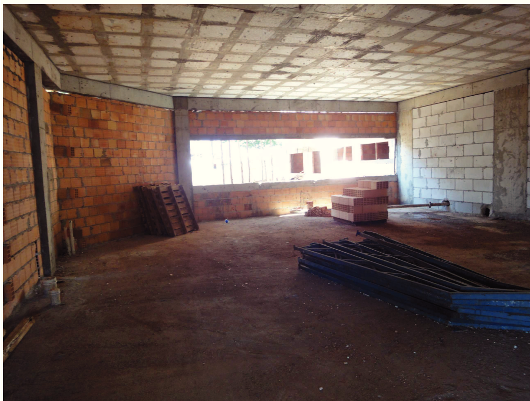
Foto 02 – Vista interna de sala do térreo – central de atendimento PJe
