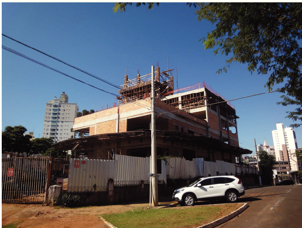
Foto 01 – Estágio atual da obra finalização da estrutura do reservatório
