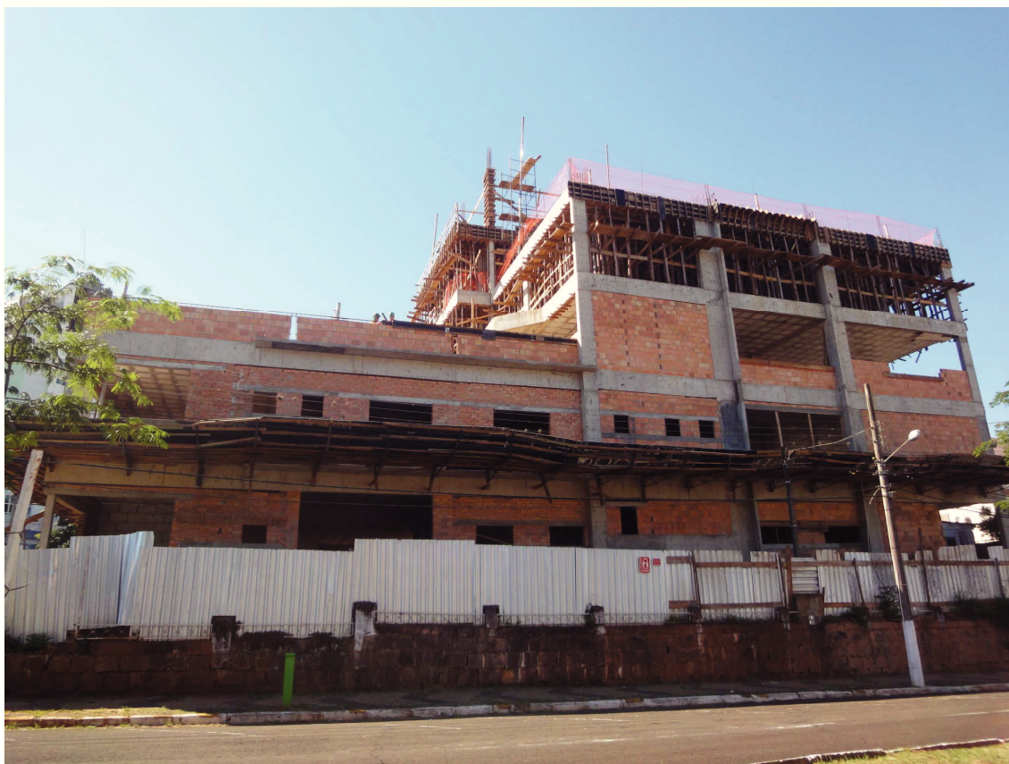
Foto 04 – Vista lateral da obra – alvenarias do térreo e primeiro pav. Concluídas, execução da alvenaria do 1º tipo
