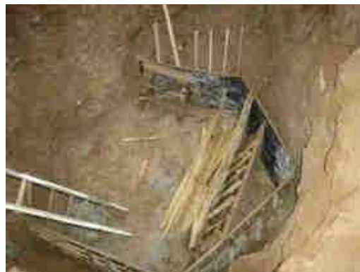
Caixaria do bloco dos pilares 18 e 22.
