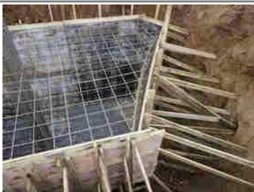
TRAVAMENTO E CONFERÊNCIA DAS FORMAS
