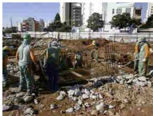
COLOCAÇÃO DA FERRAGEM
