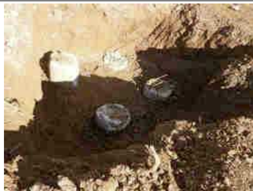
PREPARO DO TERRENO
