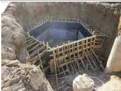
Execução de Caixaria
