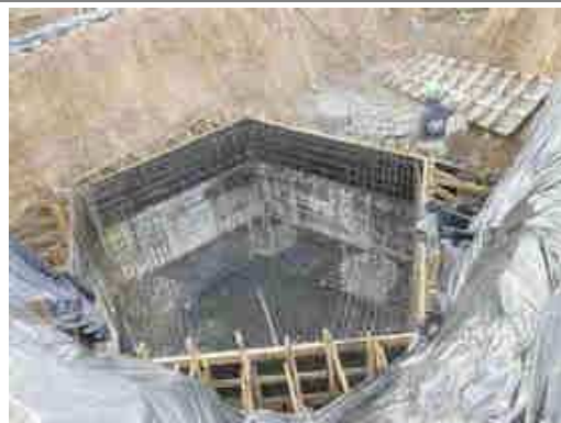
Caixaria do bloco dos pilares 18 e 22.
