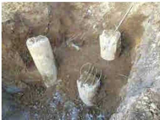
ROMPIMENTO DAS ESTACAS
