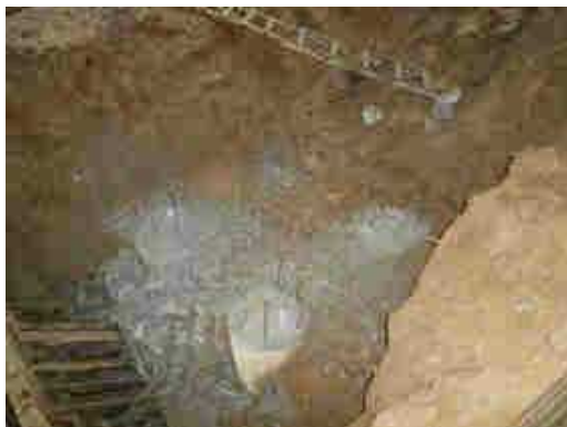
Estacas Rompidas até a cota de arrasamento.
