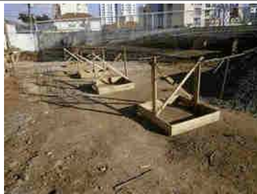
Execução de ferragem baldrame
