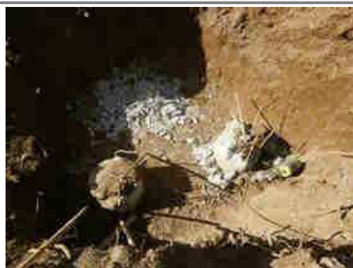
ROMPIMENTO DAS CABEÇAS DAS ESTACAS
