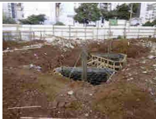
TRAVAMENTO E CONFERÊNCIA DAS FORMAS
