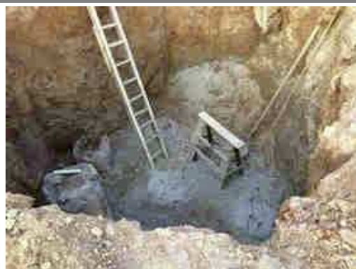
ROMPIMENTO E PREPARO CABEÇA DE ESTACAS
