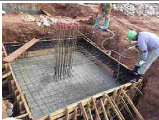
CONCRETAGEM DOS BLOCOS
