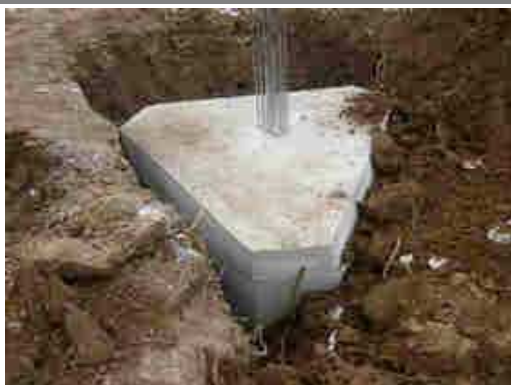
DESFORMA E ATERRO
