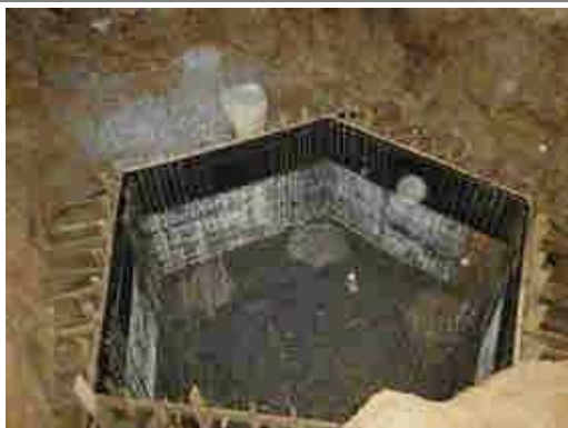
Estacas Rompidas até a cota de arrasamento.
