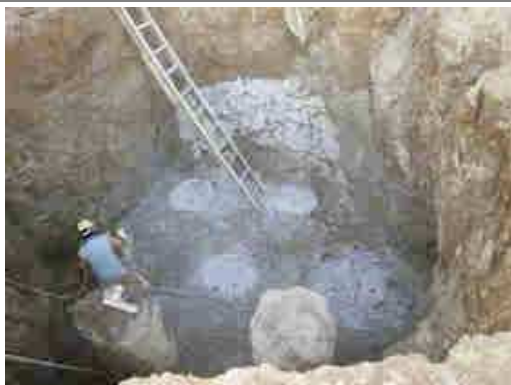
ROMPIMENTO DAS ESTACAS
