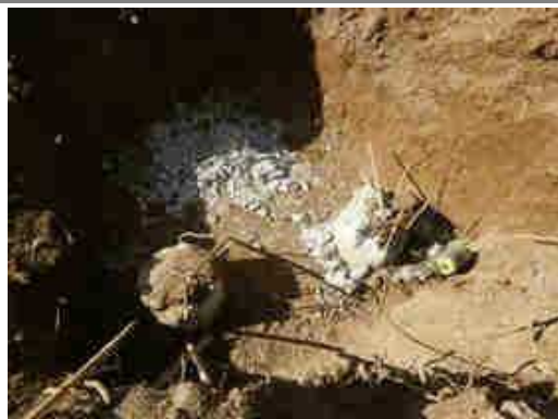
ROMPIMENTO DE ESTACAS
