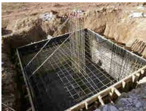
FERRAGEM TRAVADA PRONTA PARA CONCRETAGEM
