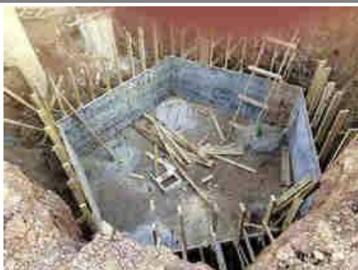
EXECUÇÃO DA CAIXARIA
