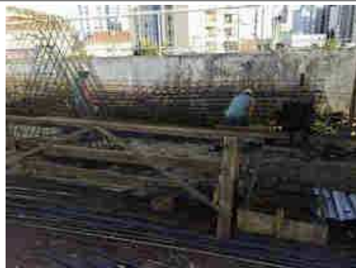
ARMAÇÃO DAS VIGAS DE BALDRAME
