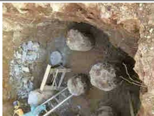
CORTE E PREPARO DE ESTACAS
