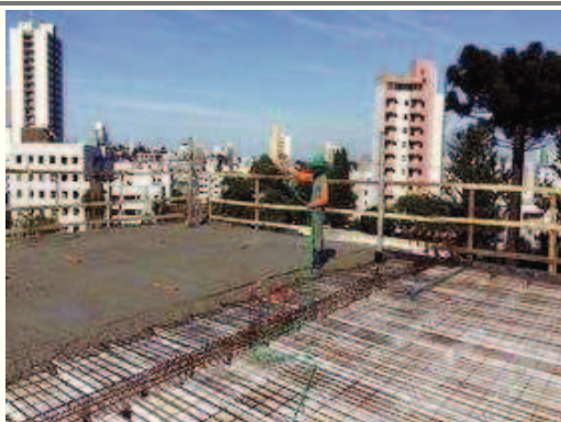
Cura da laje.
