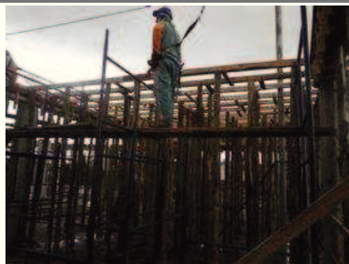
Montagem do fundo da laje
