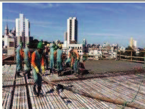
Concretagem da laje.
