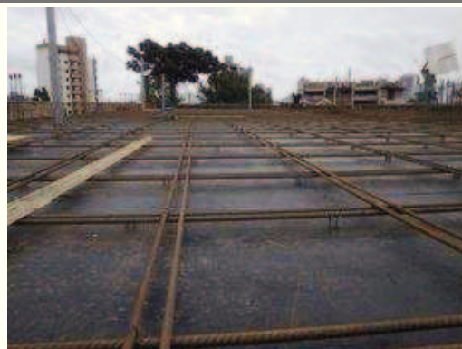
Início da colocação das nervuras.
