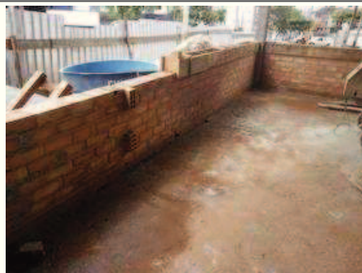
Alvenaria pavimento térreo.
