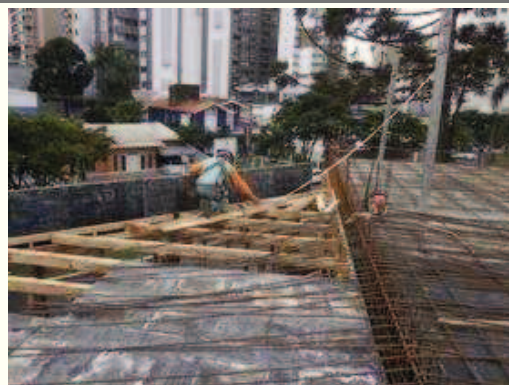
Montagem do fundo da laje
