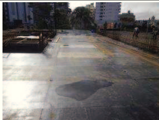
Assoalho da laje, colocado.
