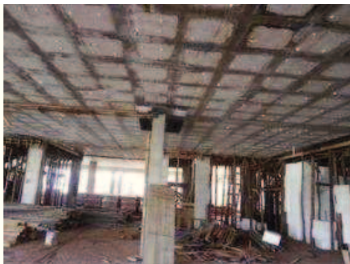
Início da desforma da laje do Térreo
