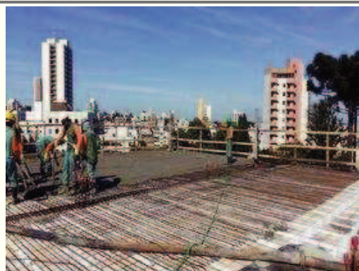
Concretagem da laje.
