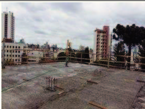
Cura da laje.
