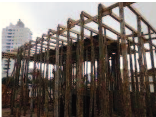
Fundo da laje
