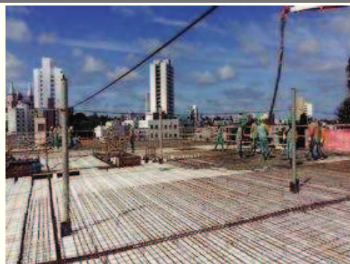
Concretagem da laje.
