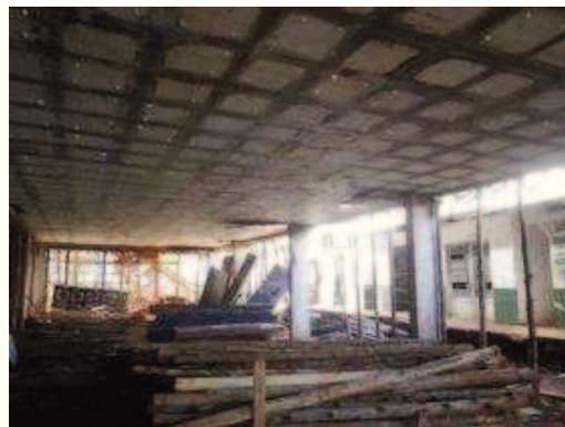
Início da desforma da laje do Térreo
