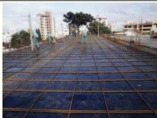
Assoalho da laje, colocado.
