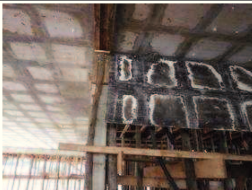
Início da desforma da laje do Térreo
