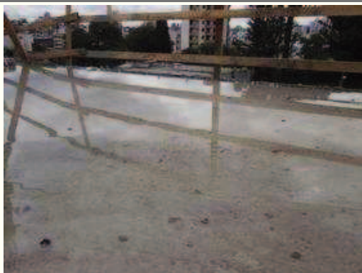
Cura da laje.
