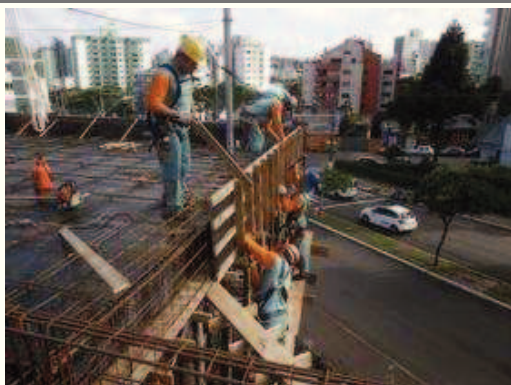
Início da colocação das nervuras.
