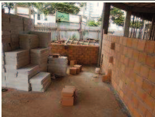
Alvenaria pavimento térreo.
