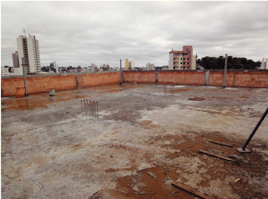
Foto 03 – Finalização da alvenaria da platibanda do último pavimento (esperas da estrutura para futura ampliação) laje que receberá telhado comum
