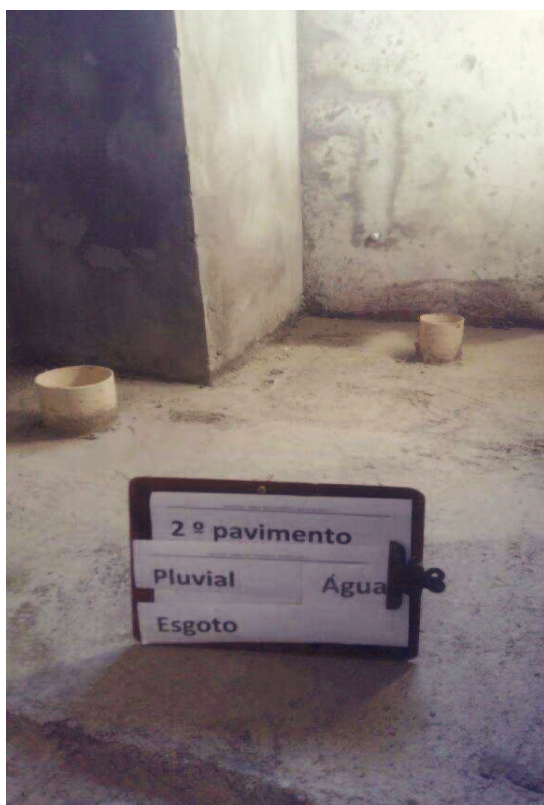
Imagem segundo pavimento – Shafts finalizados e rebocados
