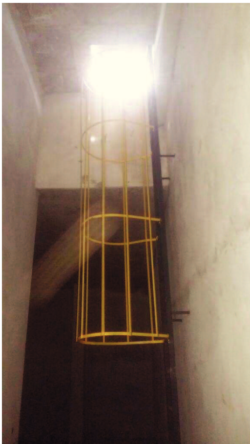
Imagem escada marinheiro
