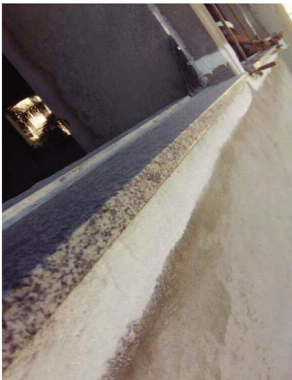
Imagem terceiro pavimento – Instalação dos contramarco em todos os pavimentos
