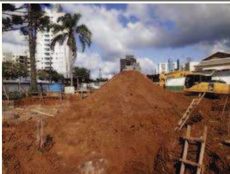
Escavação de blocos 20/07/2015 - Formas
