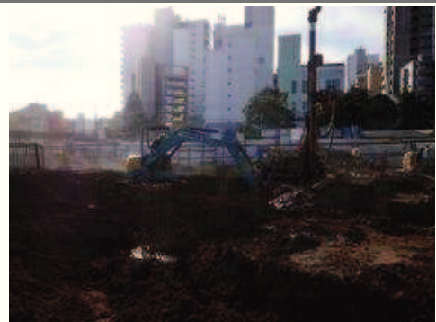
Movimentação de terra e Perfuração de Estaca
