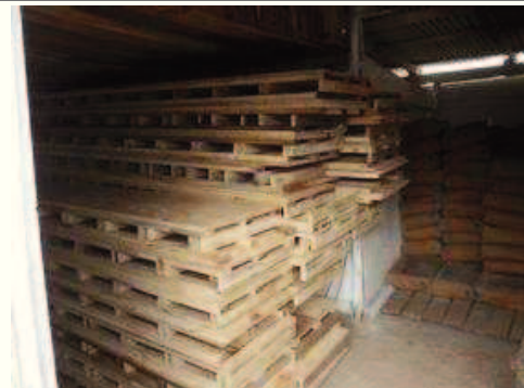
Formas vigas de baldrame
