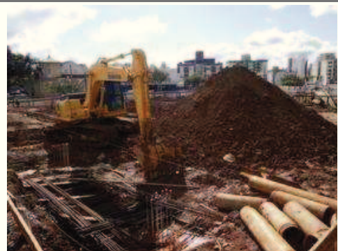
Escavação de blocos 21/07/2015 - Blocos
