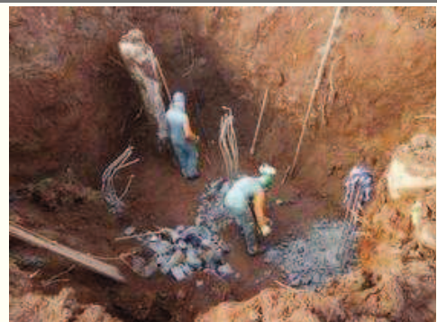
Rompimento da cabeça das estacas. 30/07/2015 - Formas
