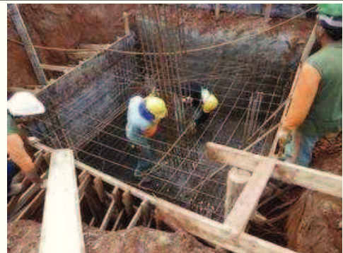
Armadura 28/07/2015 - Blocos
