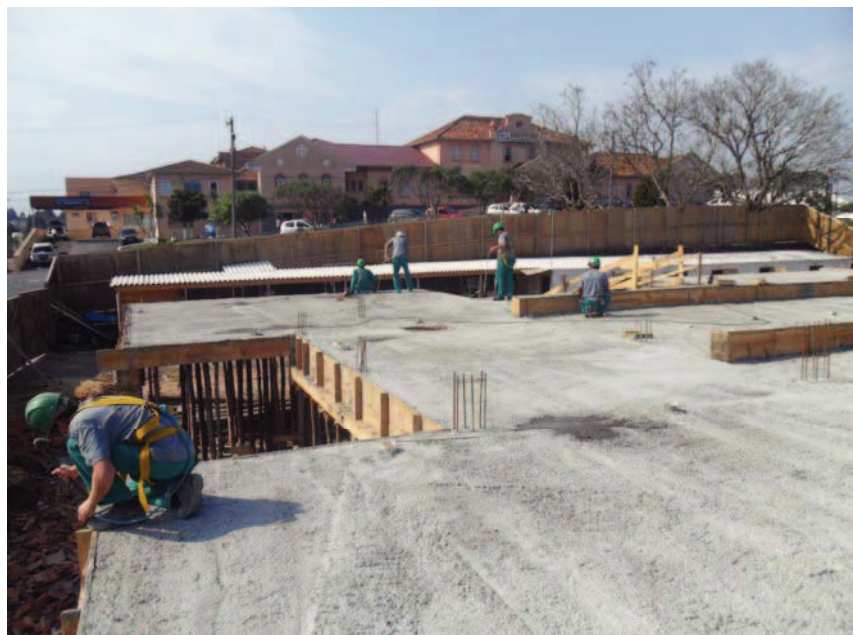
Concretagem Laje
