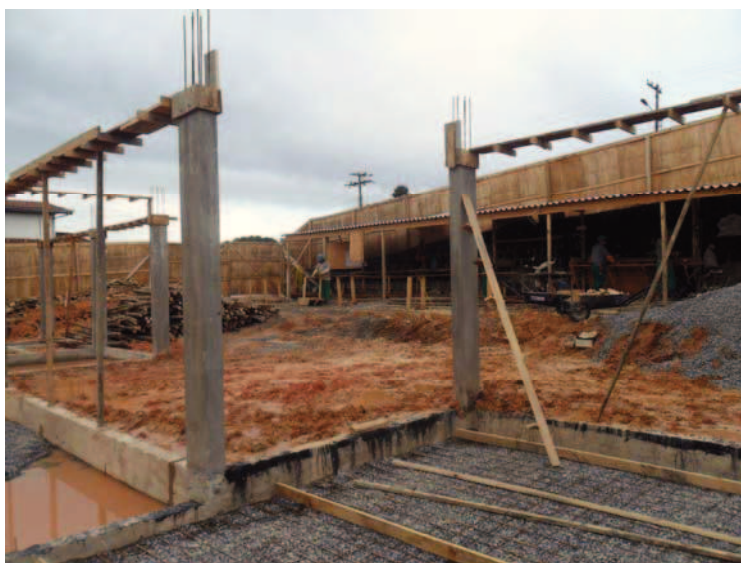
Limpeza e Organ. Canteiro
