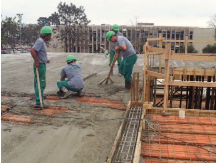
Concretagem de Vigas e Laje
