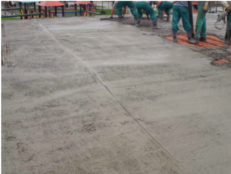
Concretagem Laje
