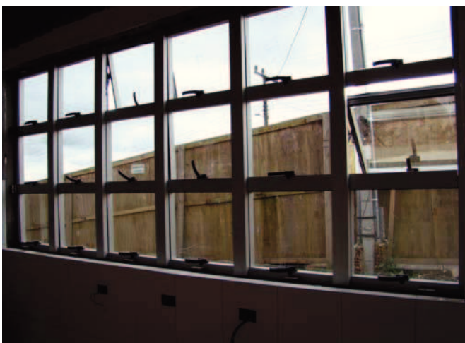
Foto 02 -Detalhe Int. Janelas (Copa)
