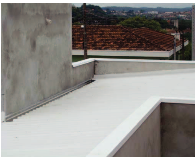
Foto 03 - Detalhe Cobertura - Fixação de Parafusos, Rufos e Calhas
