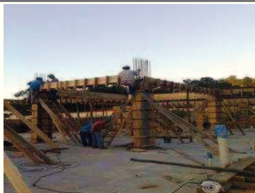
Vigas e pilares Térreo;
