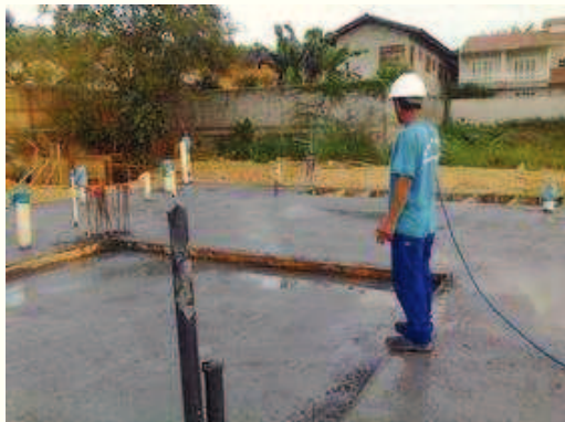
Concreto laje pavimento baldrame;
