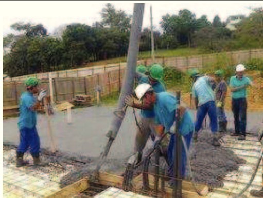
Laje, muro de contenção, vigas e pilaretes do pavimento baldrame;
