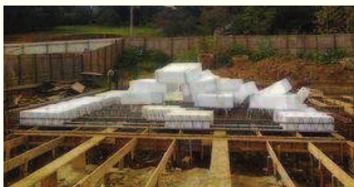
Montagem da Laje;
