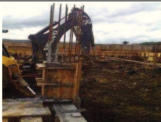
Reaterro da Cisterna;
