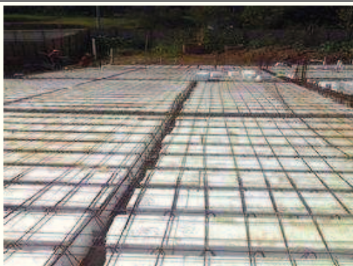
Montagem da laje e execução da ferragem;
