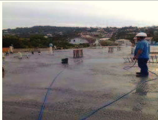
Concreto laje pavimento baldrame;
