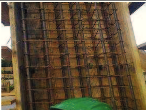
Espaçadores nos pilares Térreo;
