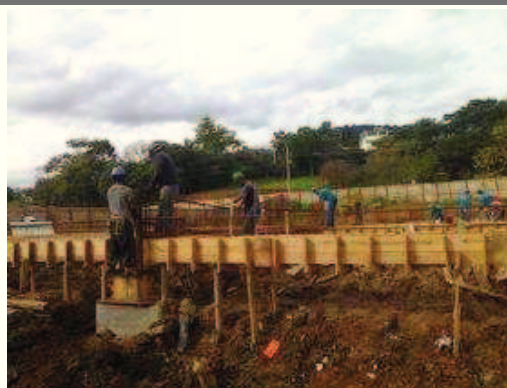
Montagem da ferragem;
