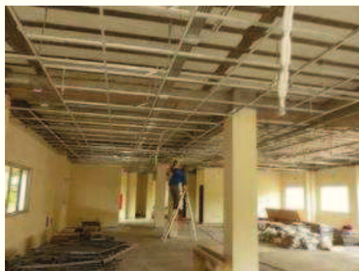
Execução estrutura forro pavto térreo
