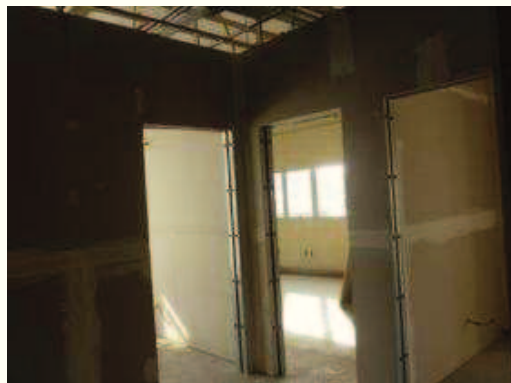
Execução paredes dry wall
