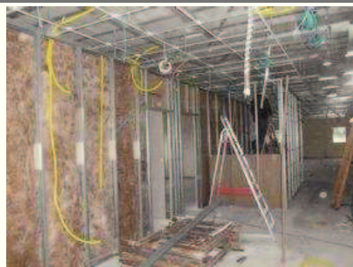
Coloca??o de paredes divis?rias com tubula??o el?trica embutida
