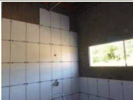
Revestimento cerâmica vetiários
