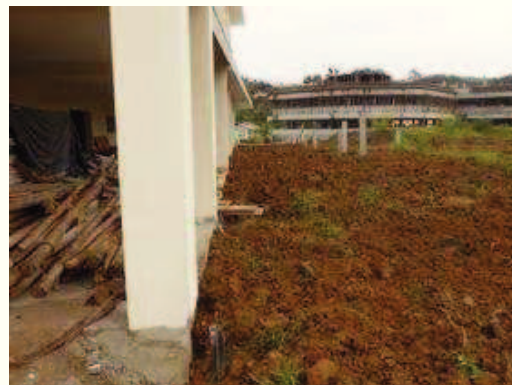
Serviços de nivelamento do pátio
