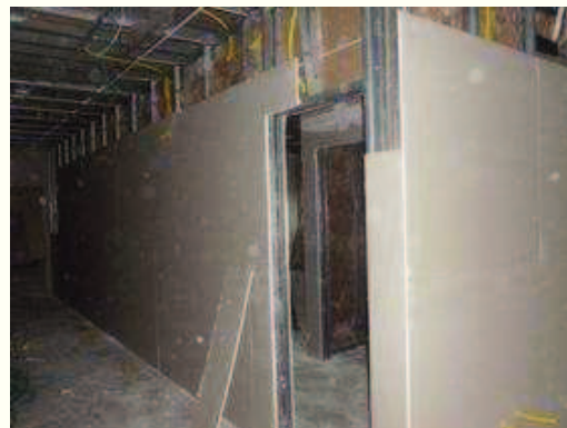
Execução de paredes de dry wall
