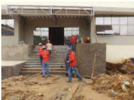
Colocação pedras escada frontal
