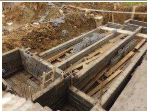
Execução Blocos rampa de acesso
