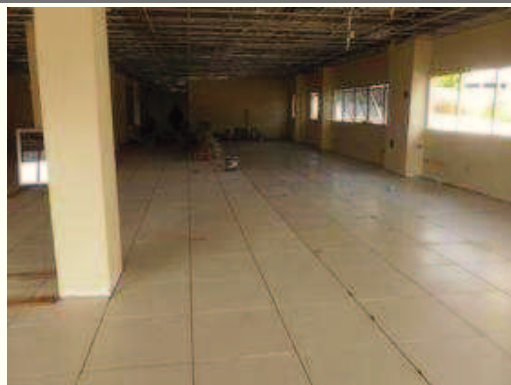
Execução revestimento piso térreo porcelanato
