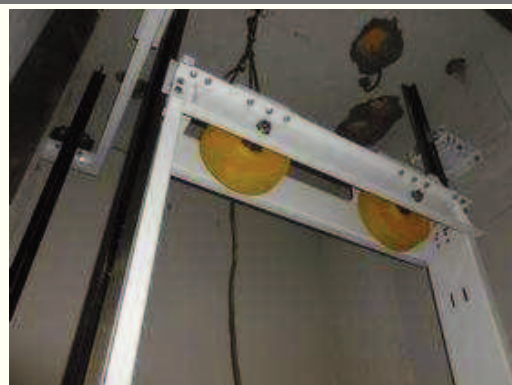
Estrutura aplicação de selador paredes de dry wall
