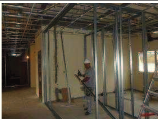
Execução de paredes de dry wall tipo 01
