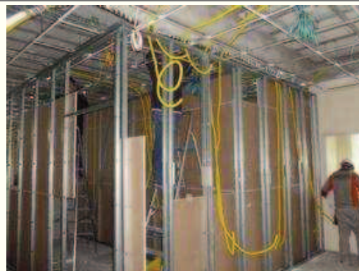
Coloca??o de paredes internas Dry wall
