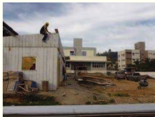
Desmontagem barraco área de vivência
