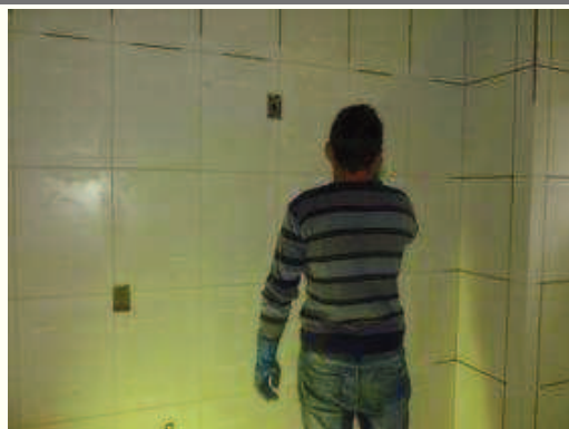
Execução rejunte azulejos
