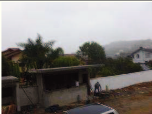
Reboco guarita e lixeira
