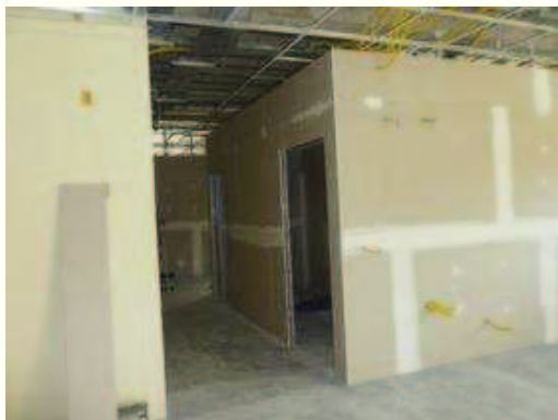
Execução de eletrodutos e caixas nas paredes de dry wall
