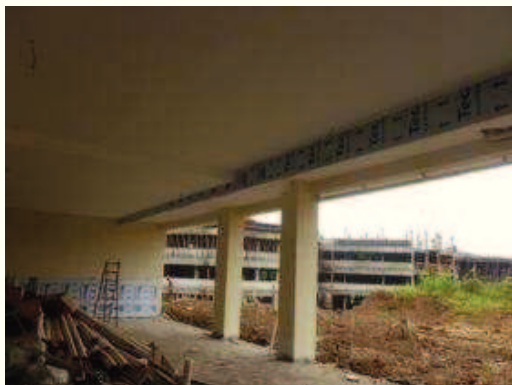
Estrutura forro garagem
