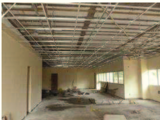
Execução de contra piso
