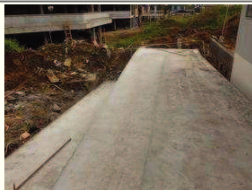
Limpeza e nivelamento terreno
