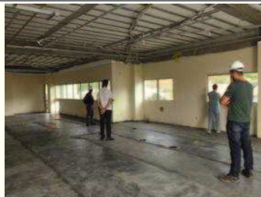
Execução de contra piso
