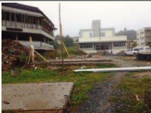
Desmonte canteiro de obras
