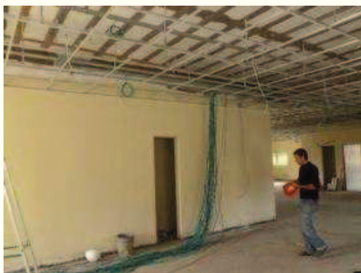
Execução fiação tipo 01
