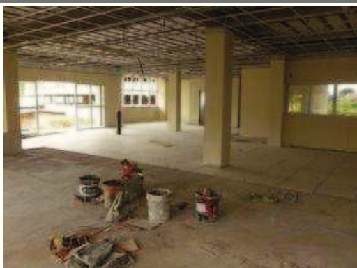
Execução piso porcelanato pavto térreo
