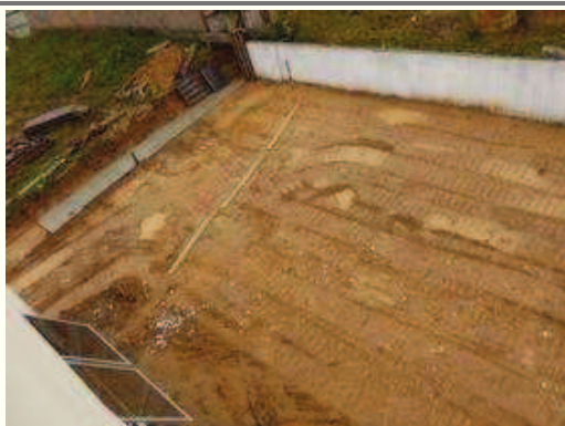
Limpeza e nivelamento terreno
