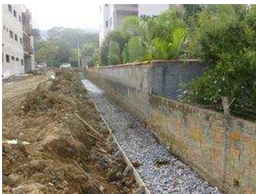
Foto mostra serviços cancha de muro de extrema
