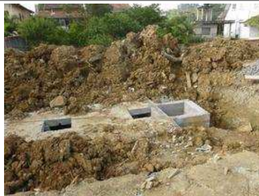
Foto mostra alvenaria executada sob e sobre e contra verga janelão lateral
