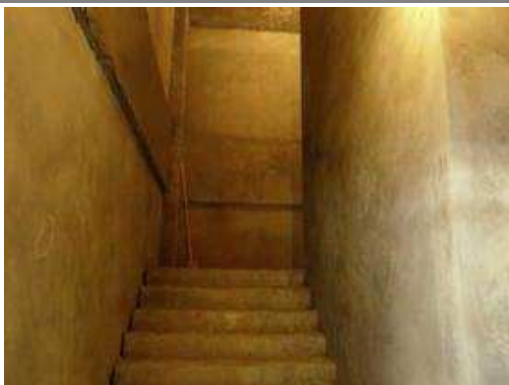
Foto mostra serviços de reboco nas paredes das escadas
