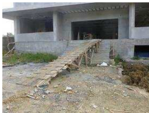
Foto mostra rampa de madeira para acesso de materiais na obra
