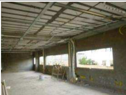
Foto mostra serviços de execução de tubulação de ar condicionado conforme informado em diário ja enviado
