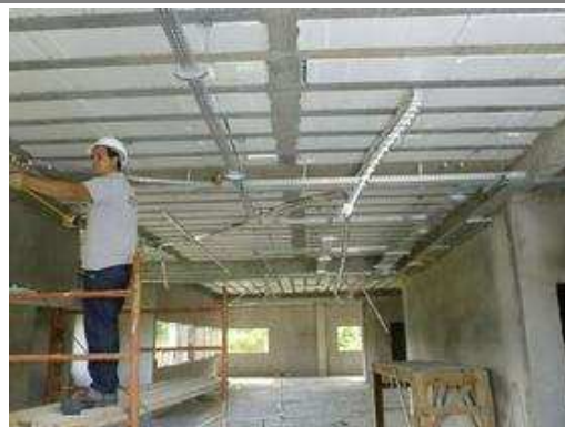
Foto mostra serviços de execução de eletrocalhas
