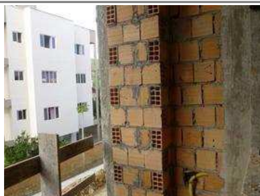
Foto mostra serviços de execução de
