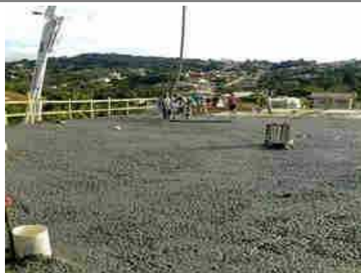
Laje teto térreo;
