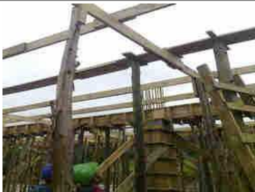
Laje teto 1º Pavimento;
