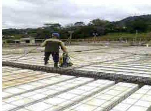
Laje teto térreo;
