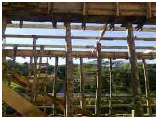
Laje Teto 1º Pavimento;
