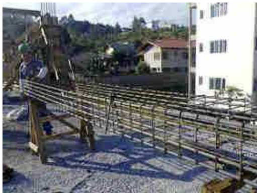
Vigas Teto 1º Pavimento;
