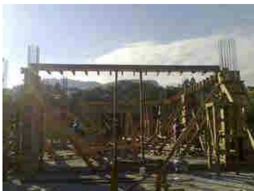
Vigas Teto 1º Pavimento;
