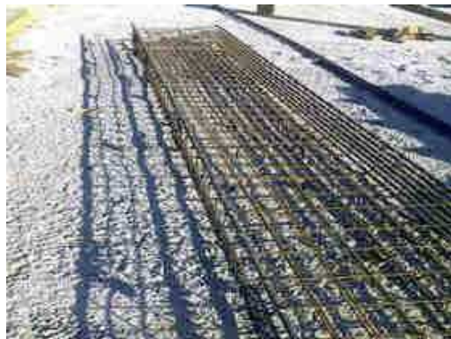
Vigas Teto 1º Pavimento;
