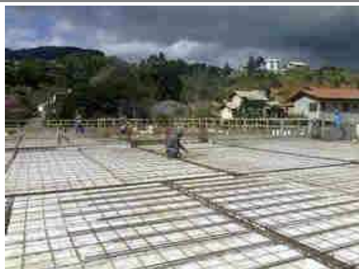
Armadura negativa laje teto térreo;
