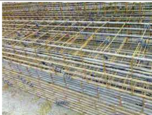
Vigas Teto 1º Pavimento;
