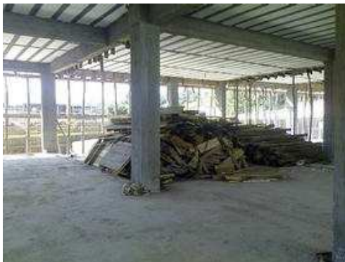
Canteiro de obra; 12/08/2014 - Limpeza e organização;
