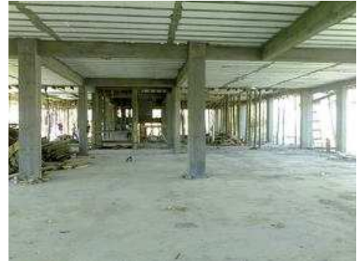
Canteiro de obra; 12/08/2014 - Cura
