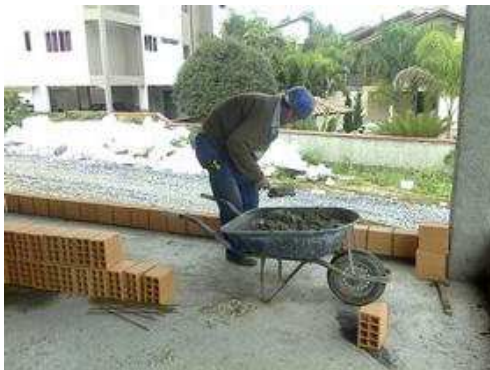
Pavimento Térreo; 20/08/2014 - Formas
