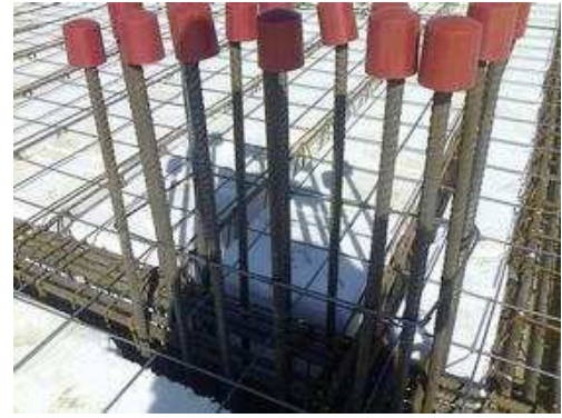
Colocação de Estribo; 11/08/2014 - Limpeza
