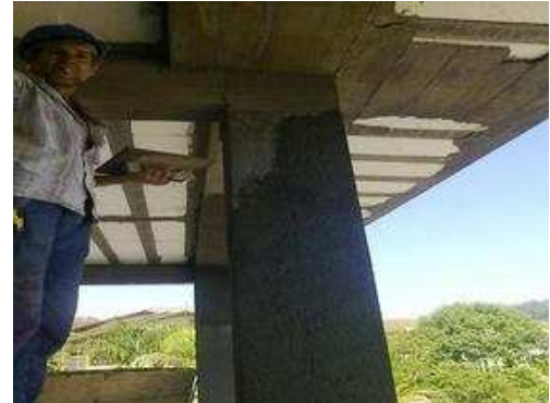
Pilares Térreo; 20/08/2014 - Alvenaria
