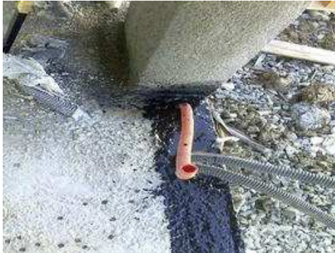
Vigas Baldrame; 20/08/2014 - Alvenaria
