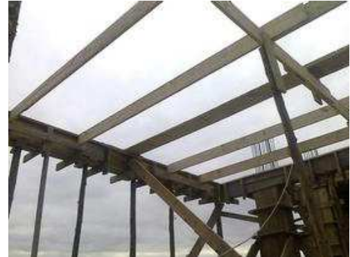
Laje Teto 2º Pavimento
