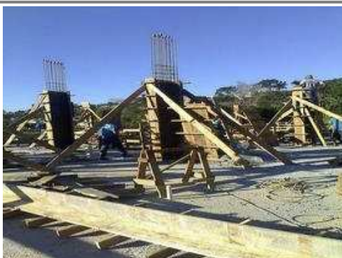
Pilares 2º Pavimento; 26/08/2014 - Alvenaria
