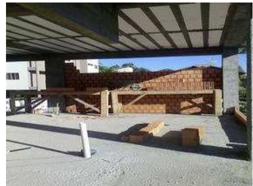
Pavimento Térreo; 21/08/2014 - Formas
