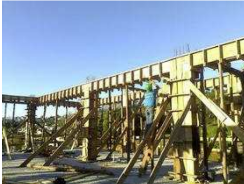
Vigas teto 2º Pavimento;
