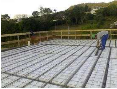
Armadura Negativa; 07/08/2014 - Concretagem
