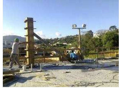
Pilares 2º Pavimento; 19/08/2014 - Chapisco
