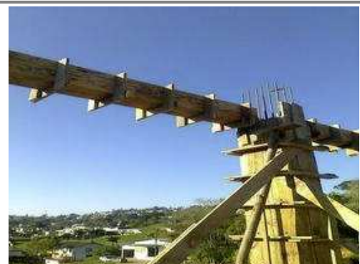
Vigas teto 2º Pavimento; 26/08/2014 - Alvenaria
