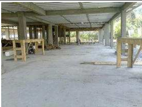
Canteiro de obra; 18/08/2014 - Formas
