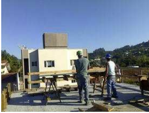
Pilares 2º Pavimento; 19/08/2014 - Impermeabilização
