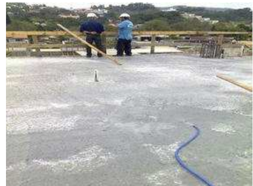
Concreto laje teto 1º Pavimento; 15/08/2014 - Caixa
