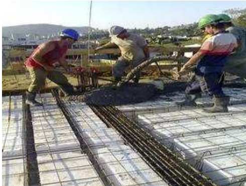
Laje teto 1º pavimento; 11/08/2014 - Limpeza e organização;
