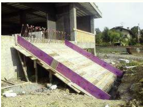
Escada acesso pavimento térreo;
