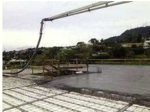
Concretagem laje teto 2º pavimneto;
