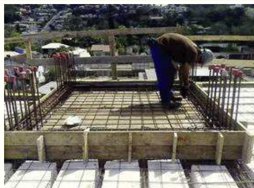
Armadura Positiva laje maciça (Elevador);
