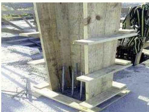
Pilares Piso Reservatório;
