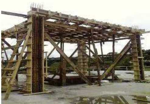
Pilares e Vigas Piso Reservatório;
