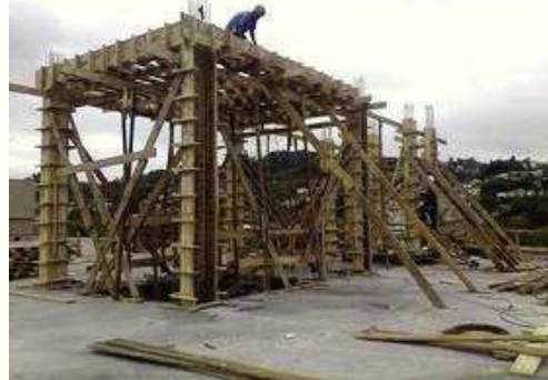
Pilares e Vigas Piso Reservatório;
