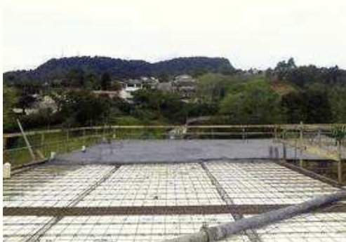
Concretagem laje teto 2º pavimneto;
