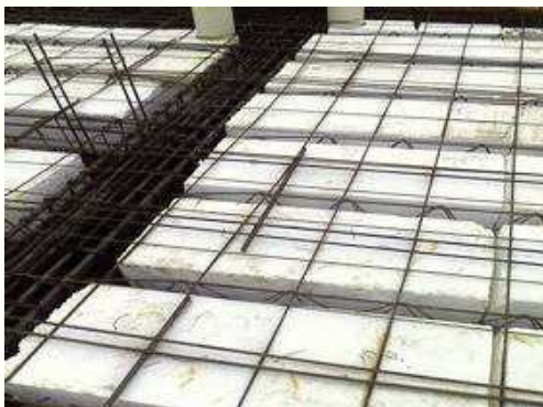
Espaçador solicitado pelo Eng Adalberto no negativo da laje;
