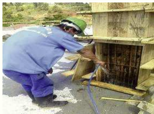
Pilares piso reservatório antes da concretagem;
