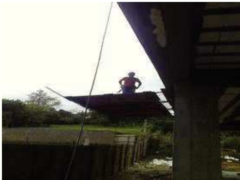
Colocação Bandeja de Proteção;
