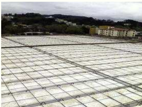
Armadura Positiva laje teto 2º pavimento;
