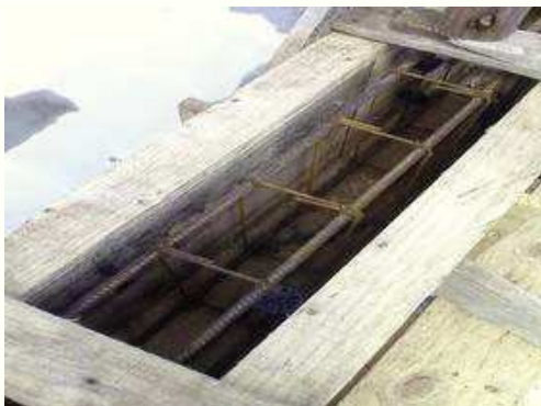
Viga Piso Reservatório;
