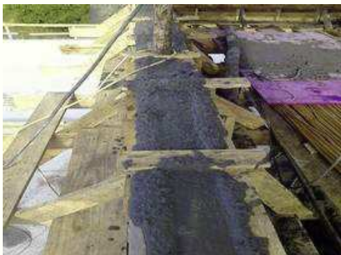
Vigas piso reservatório;
