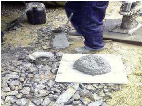
Concretagem laje teto 2º pavimneto;
