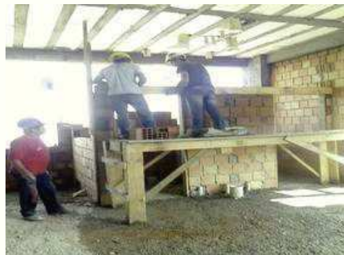
Execução Alvenaria 1º Pavimento;
