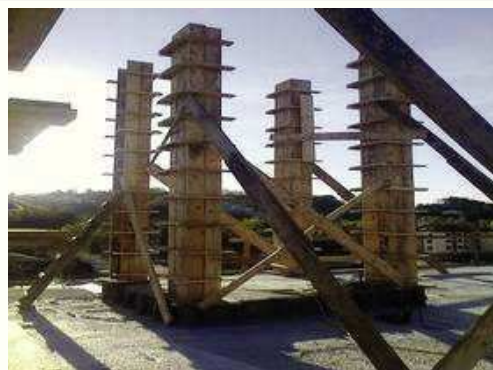
Pilares Piso Reservatório;
