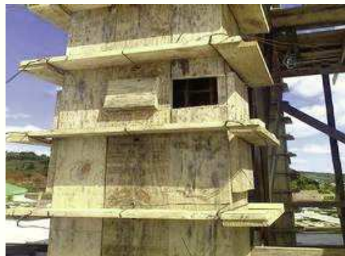
Em todos os pilares na metade, foram feito a passagem para o vibrador;
