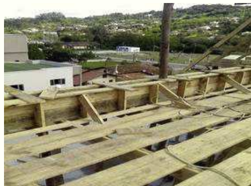
Viga Piso Reservatório;
