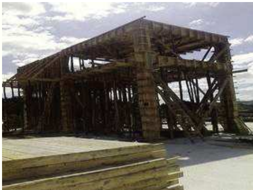
Pilares e vigas reservatório;
