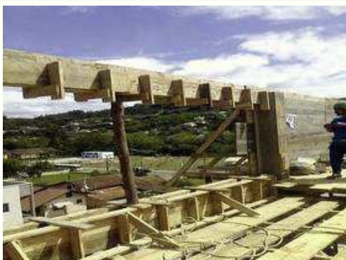
Viga Teto Reservatório;
