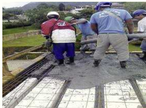
Início da concretagem;
