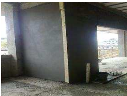
Pavimento Térreo; 09/10/2014 - Forma
