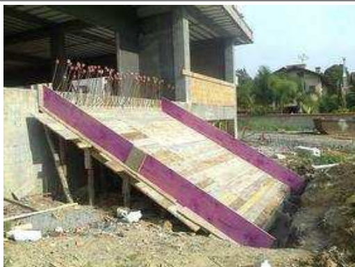
Escada acesso pavimento térreo; 14/10/2014 - Chapisco
