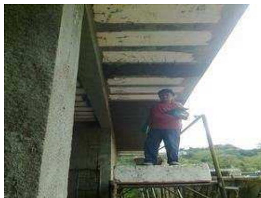
Pavimento Térreo; 09/10/2014 - Chapisco
