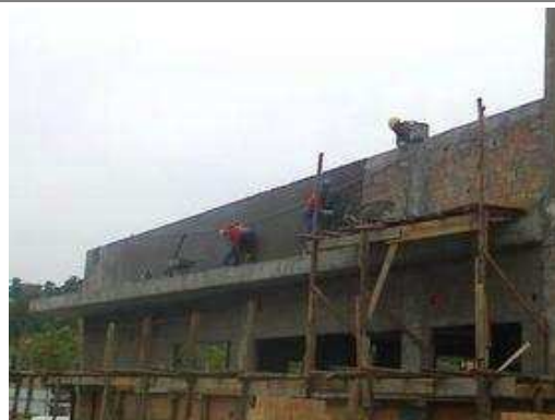
Platibanda teto térreo;
