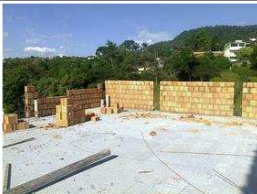
Teto 2º pavimento (Platibanda);
