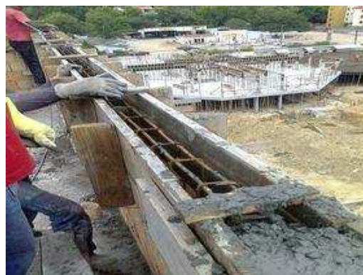
Concretagem (pilares e vigas platibanda) teto 2º pavimento;
