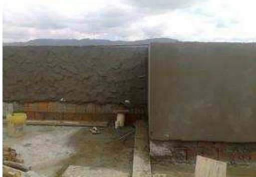
Teto 2º pavimento (Platibanda);
