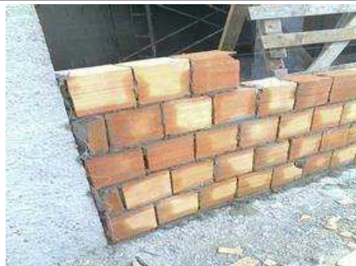
Execução alvenaria Teto 2º pavimento (casa de máquinas);
