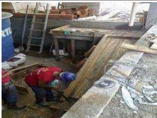
Execução forma escada cisterna;
