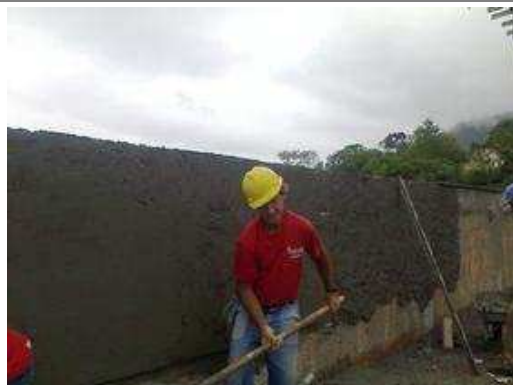
Platibanda teto térreo;
