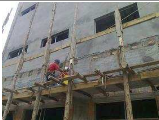
Execução reboco externo 1º Pavimento;
