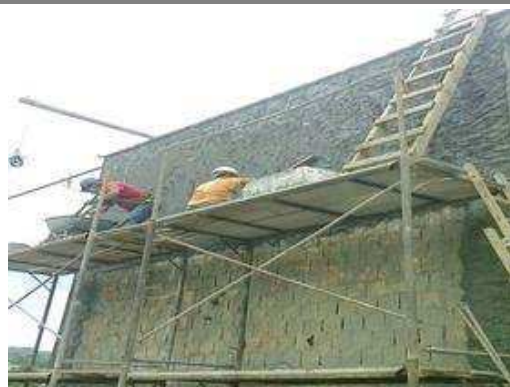
Execução de reboco externo Reservatório;
