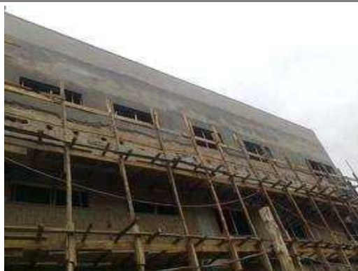
Execução de reboco externo 2º pavimento;
