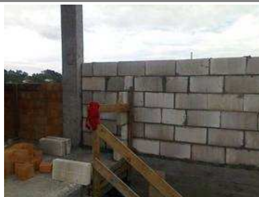
Execução alvenaria teto 2º Pavimento (Casa de máquinas);
