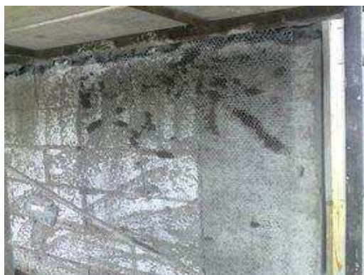
Execução reboco externo com tela;
