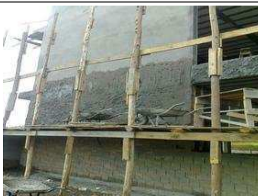
Execução de reboco externo 1º Pavimento;
