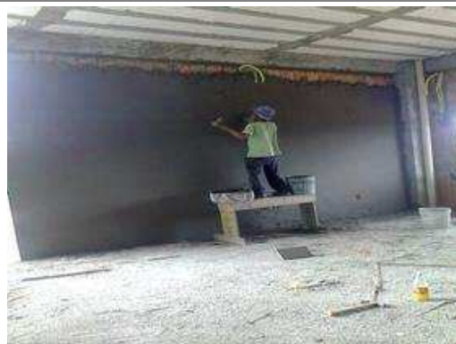
Reboco Interno (2º Pavimento);
