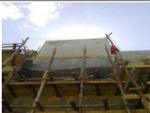
Platibanda teto 2º Pavimento, 2º Pavimento e Casa de máquina;
