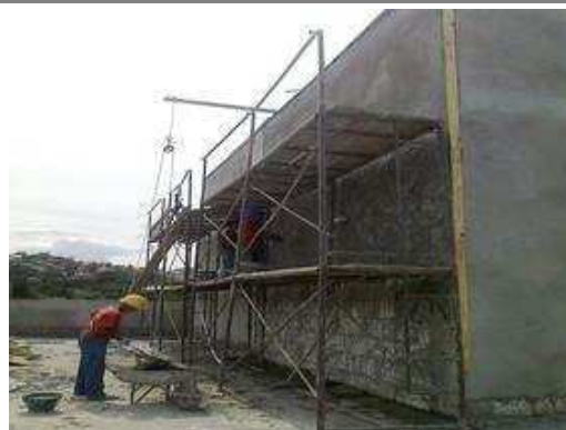
Execução reboco externo Casa de máquinas;
