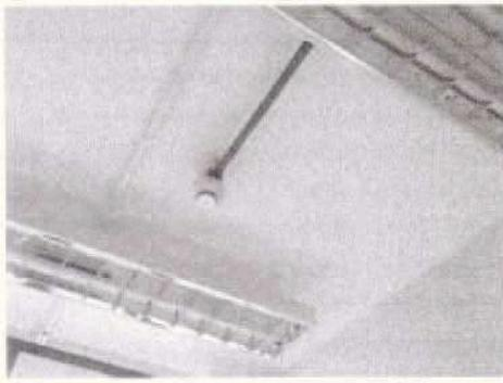
Instalação da fiação e dos detectores de fumaça
