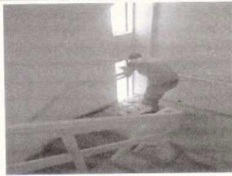
Troca de vidros aramados que estavam quebrados/trincados na escadaria.
