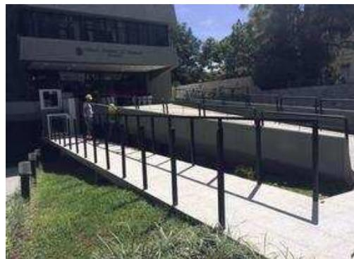
Instalação de perfis para guarda corpo em vidro temperado - Passarela PNE.
