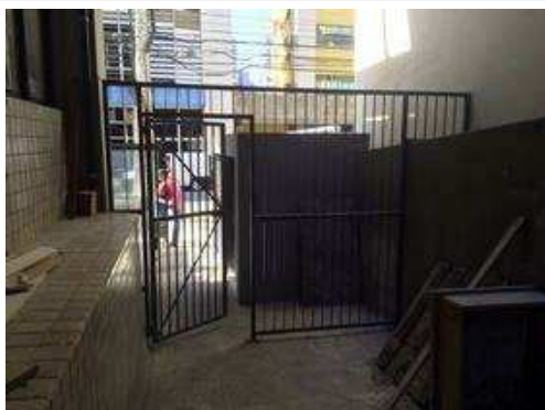
Instalação do portão de acesso
