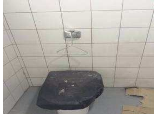
Instalação de acabamentos válvula descarga
