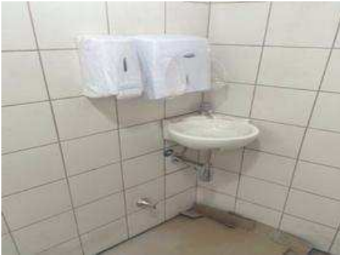
Instalação de porta papéis
