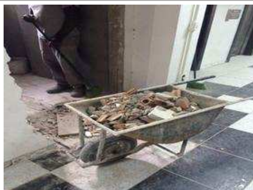
Demolição de paredes
