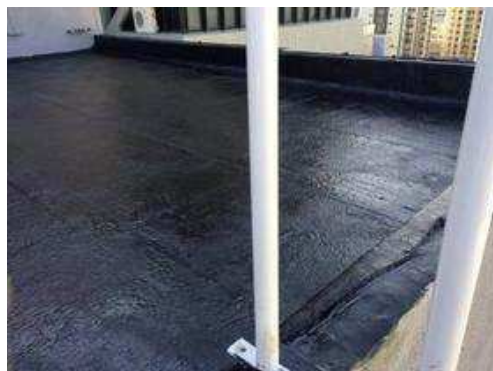
Reparo de reboco em toda a volta da cobertura e impermeabilização
