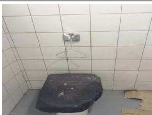
Instalação de alavanca de descarga PNE
