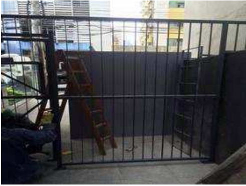
Pintura do portão de acesso lateral
