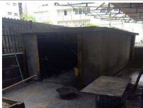
Reboco casa de gases
