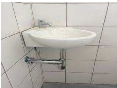
Instalação de sifão nas cubas
