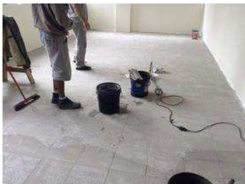
Regularização de piso 1º pavimento
