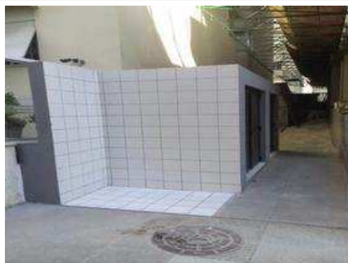
Instalação de azulejo piso lixeira
