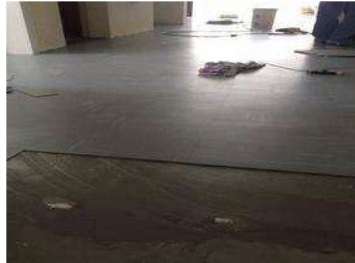
Instalação de piso vinílico pvto 1
