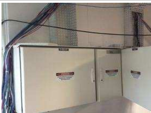
Instalação de Quadros elétricos
