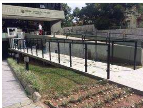
Instalação de vidro guarda corpo
