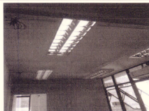
Instalações luminárias 1º pavimento
