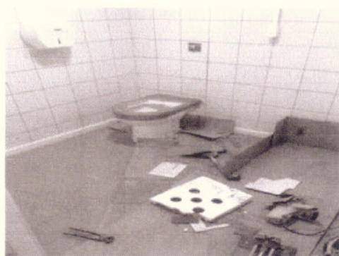
Arremate azulejo atrás vaso sanitário
