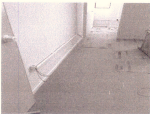
Instalação de piso vinílico
