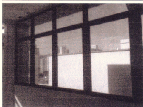
Instalação das películas 6º pvto
