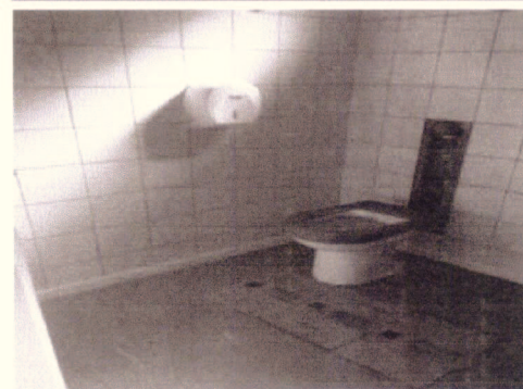
Instalação de rodapé
