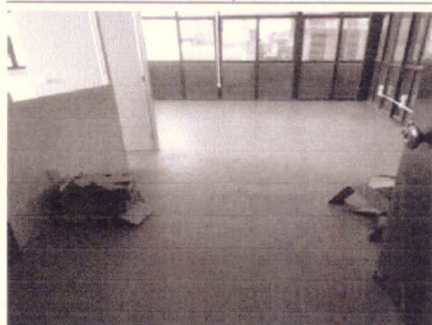
Instalação do piso vinílico em placas ático
