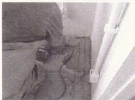
Corte de piso para passagem de tubulação de ar comprimido
