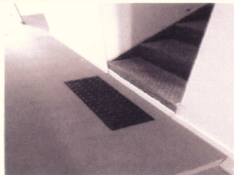
Instalação de placa tátil em borracha
