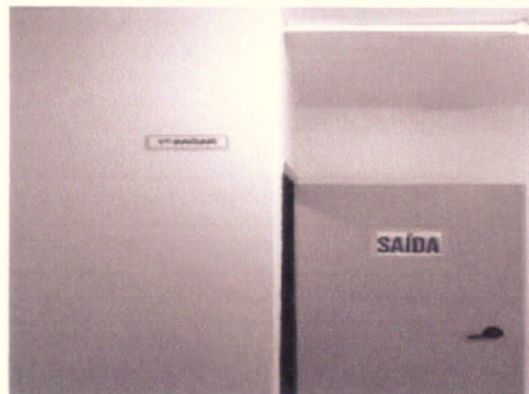
Instalação de placas de saída e identificação dos andares
