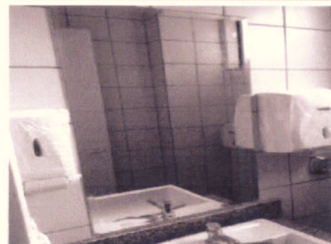
Instalação de espelhos
