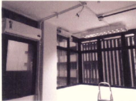
Instalação de Ar Condicionado
