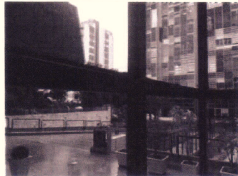
Instalação de vidros passarela de acesso
