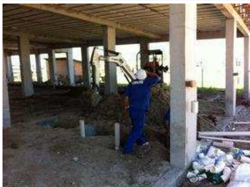
Passagem de instalações hidrossanitárias no pavimento térreo.
