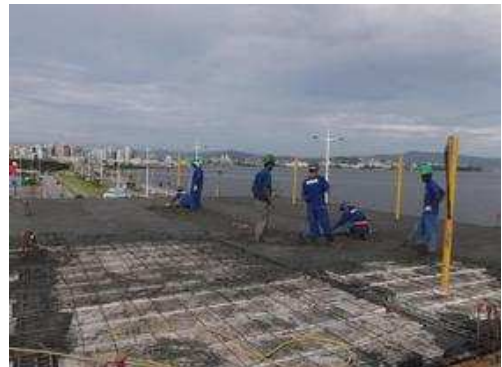
Concretagem das vigas e lajes do 2º pavimento
