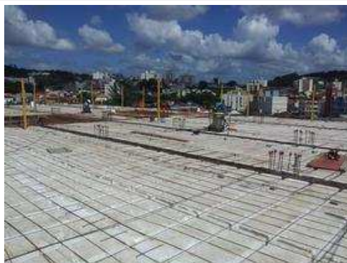
Vista da laje do 2º pavimento;
