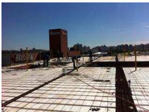
Laje do 2º pavimento.
