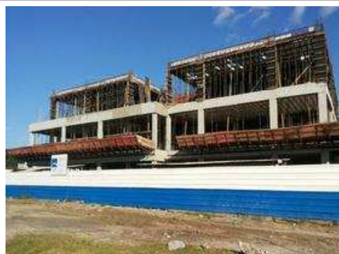
Estrutura pavimento nível térreo 2.-2
