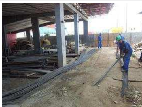
Limpeza geral da obra
