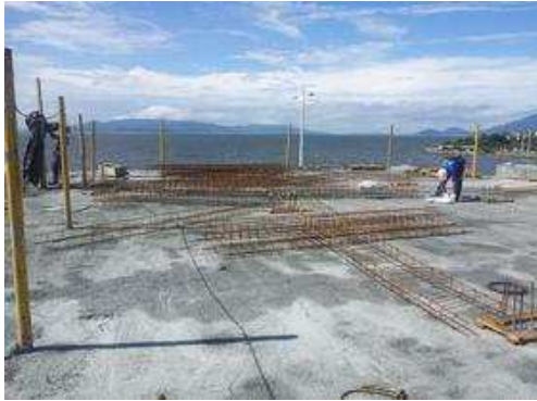
Colarinho dos pilares - 3º pavimento
