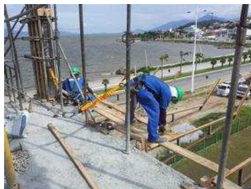
Execução do bandeirão primário.
