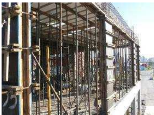
Estrutura pavimento nível térreo 2.-3
