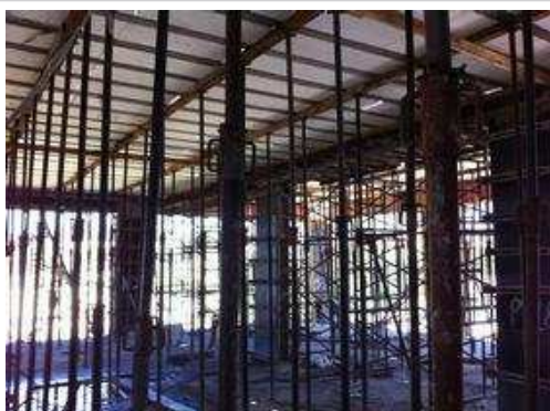
Estrutura do 2º pavimento formas vigas e pilares e escoramento da laje.
