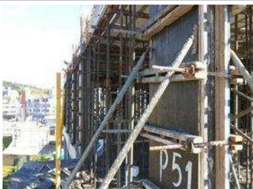
Estrutura pavimento nível térreo 2.-1
