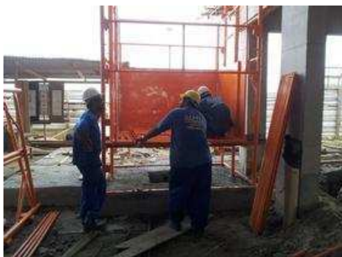
Montagem do elevador de obras
