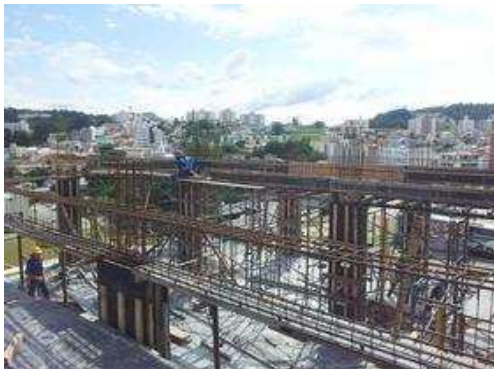
Ferragem das vigas - teto do 3º pavimento
