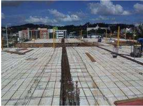
Vista da laje do 2º pavimento pronta para concretar.
