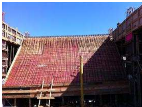
Laje inclinada maciça do 2º pavimento.
