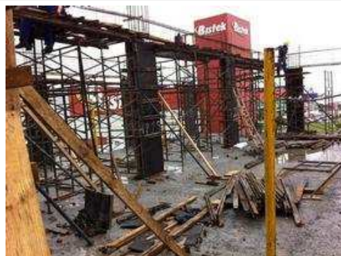
Estrutura 2º pavimento - 2.
