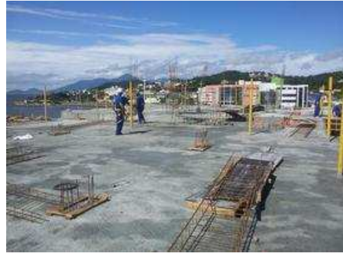
Colarinho dos pilares - 3º pavimento
