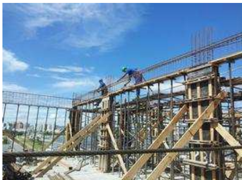
Colocação das formas e ferragem das vigas do 3º pavimento;
