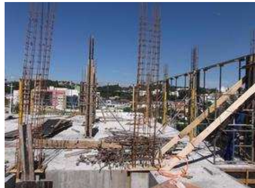
Estrutura pavimento nível térreo 3, colocação de ferragem de pilares.
