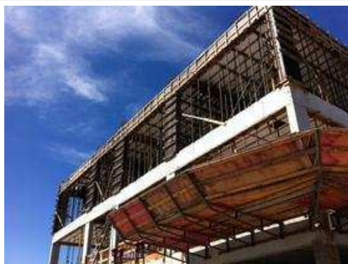
Estrutura do 2º pavimento.
