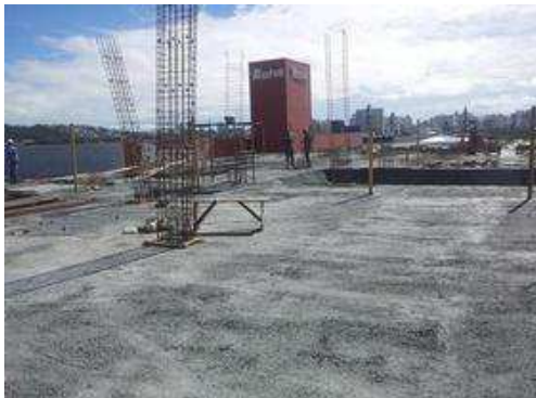
Colocação de ferragem dos pilares - 3º pavimento
