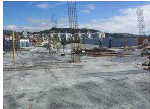
Colocação de ferragem dos pilares - 3º pavimento
