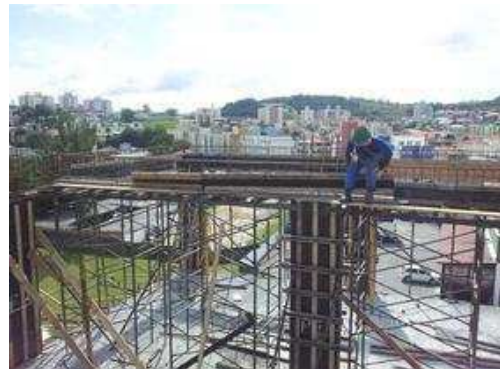
Ferragem das vigas - teto do 3º pavimento
