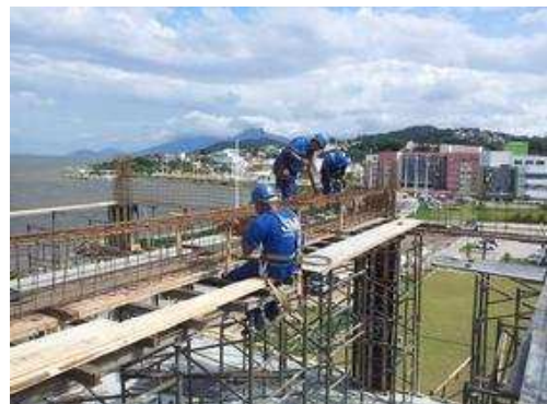
Formas dos fundos das vigas - teto do 3º pavimento
