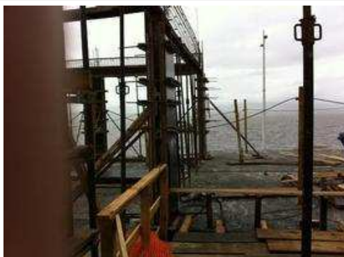
Estrutura 2º pavimento - 1.
