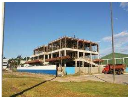
Estrutura pavimento nível térreo 2.-4
