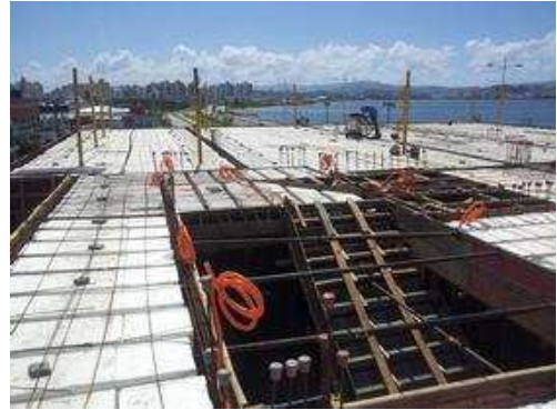
Vista da escada do 2º pavimento pronta para concretar.
