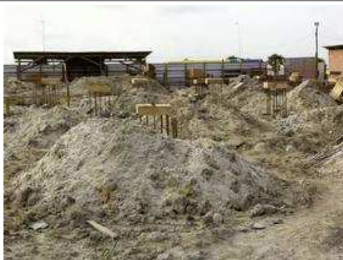
Montagem de formas e ferragem dos blocos.
