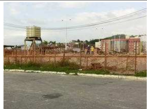
Canteiro de Obras.
