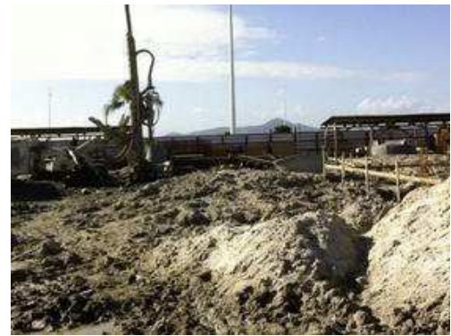
Canteiro de obras 3.
