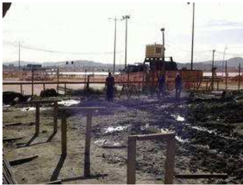
Canteiro de obras 2.
