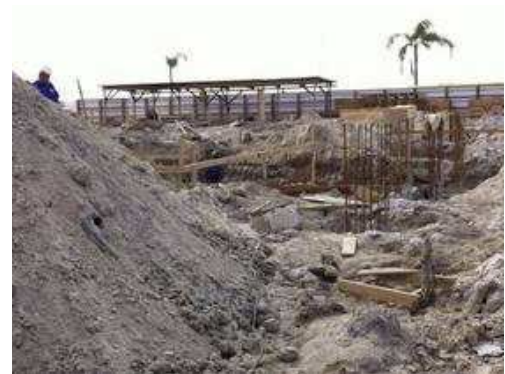
Montagem de formas e ferragem dos blocos.
