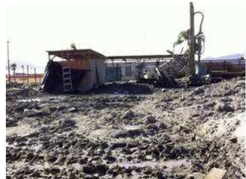
Canteiro de obras 1.
