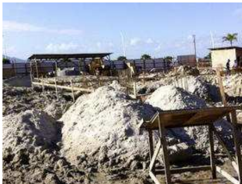
Canteiro de obras 4.
