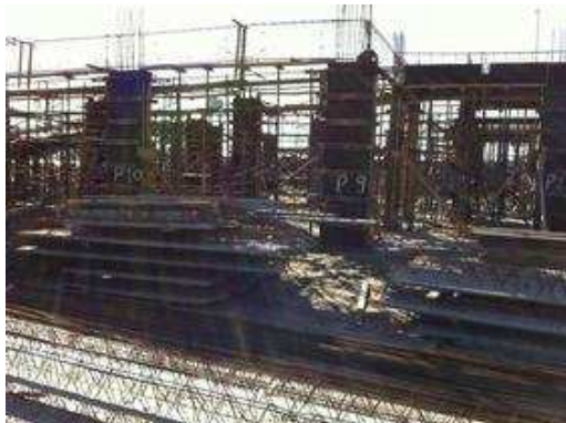
Estrutura pavimento nível térreo 3.
