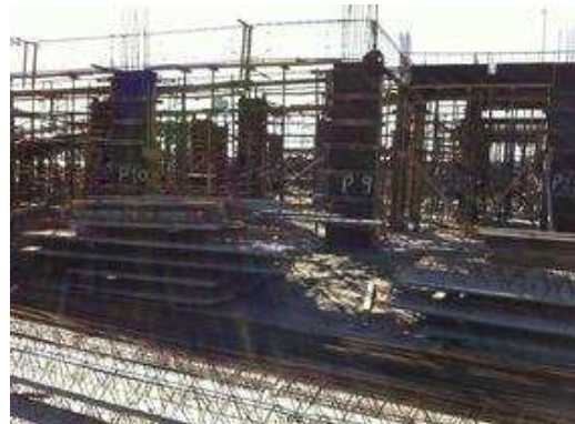
Estrutura pavimento nível térreo 4.
