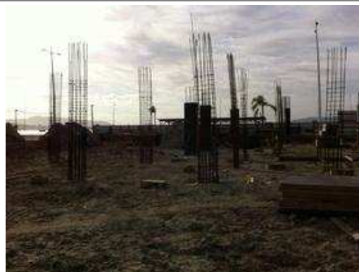
18/11/2014 - Pilares pavimento térreo 2.
