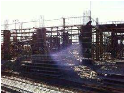
Estrutura pavimento nível térreo 1.
