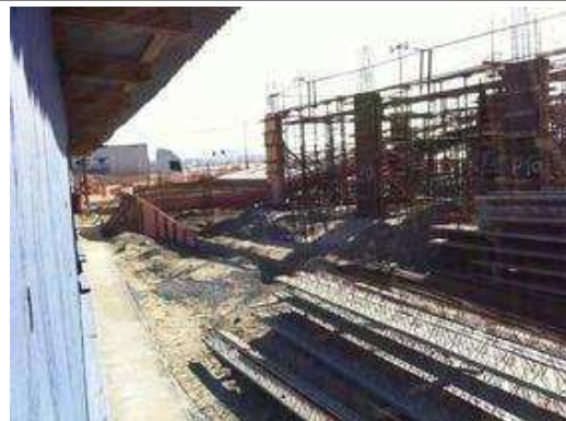
Estrutura pavimento nível térreo 2.
