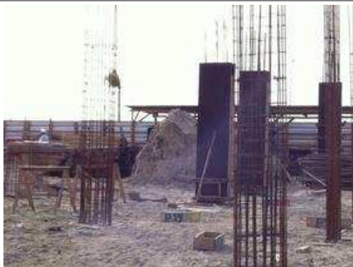
18/11/2014 - Pilares pavimento térreo 1.
