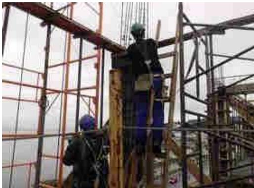
Fomas e ferragem dos pilares e vigas do 1º pavimento tipo.
