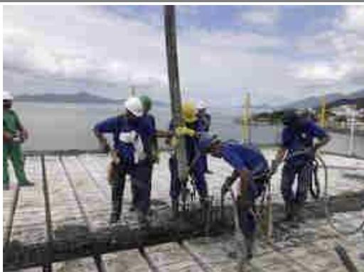
Concretagem da laje, vigas e pilares do teto do 3º pavimento.
