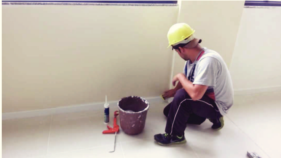
Figura 03 – Calafetação dos rodapés no 4º Pavimento
