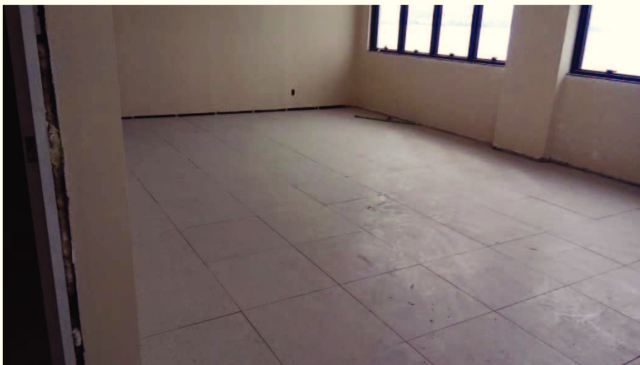
Figura 02 – Instalação do piso elevado nas salas de Audiência no 2º Pavimento.
