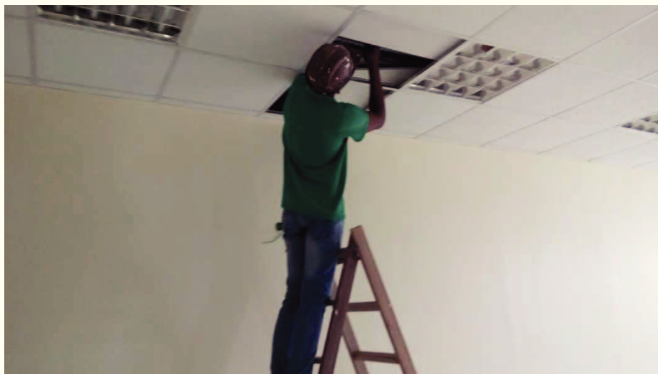
Figura 05 – Instalação de luminárias no 4º Pavimento.
