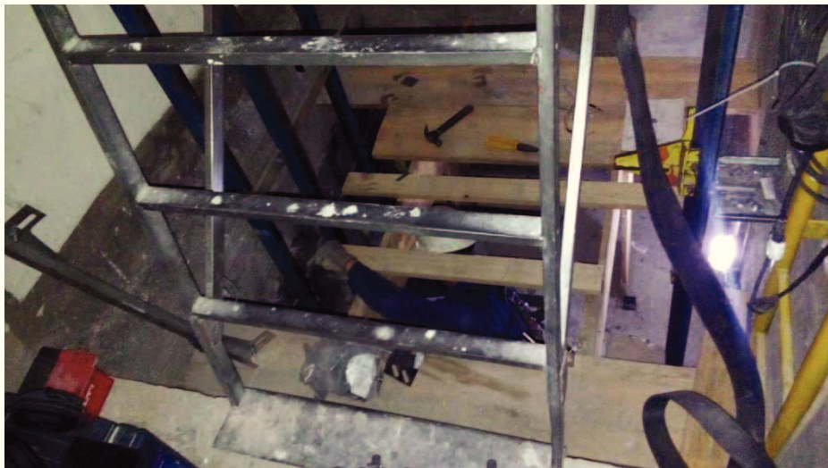
Figura 08 – Instalação do elevador.
