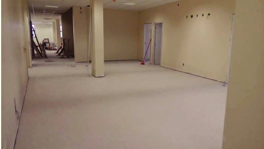
Figura 01 – Aplicação do piso Paviflex no 2º Pavimento.
