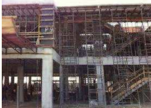
Estrutura pavimento nível térreo 1.-2
