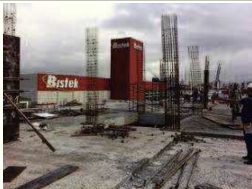
Estrutura pavimento nível térreo 1.-4
