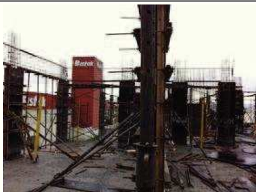
Estrutura 2º pavimento (pilares) -1
