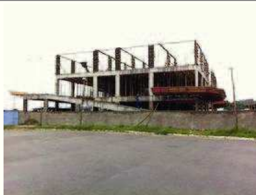
Vista ampla da estrutura de concreto armado.
