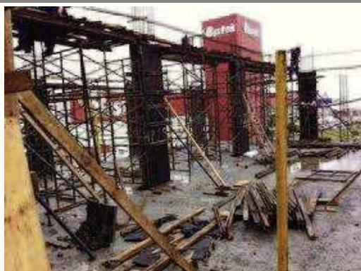
Estrutura 2º pavimento - 2.
