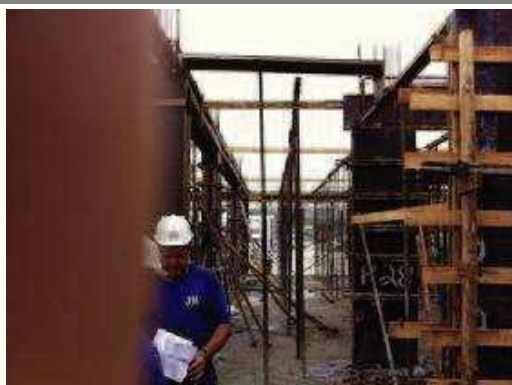
Estrutura pilares e vigas 2º pavimento - 3 18/02/2015 - Estrutura 2º pavimento - 5
