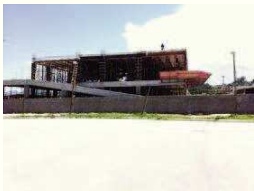
Estrutura 1º pavimento-1
