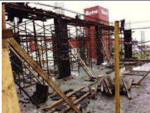
Estrutura pilares e vigas 2º pavimento - 5 20/02/2015 - Estrutura 2º pavimento - 2.
