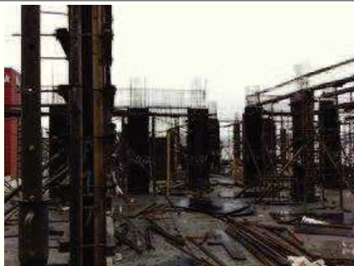
Estrutura 2º pavimento (pilares) -2
