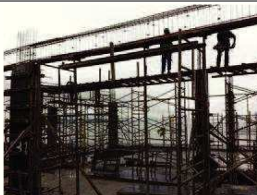
Estrutura 2º pavimento (fundos de vigas) -1
