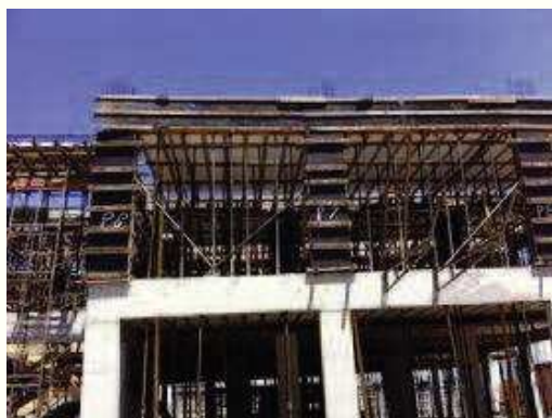
Estrutura 1º pavimento-2
