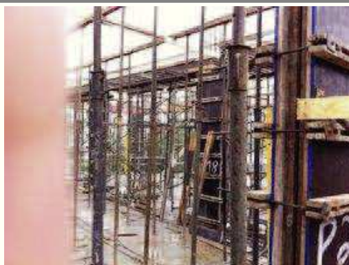
Estrutura pilares e vigas 2º pavimento - 4 20/02/2015 - Estrutura 2º pavimento - 1.
