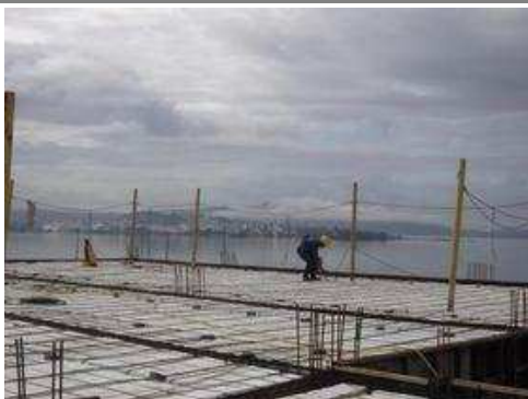
Limpeza geral da laje do pavimento tipo 1.
