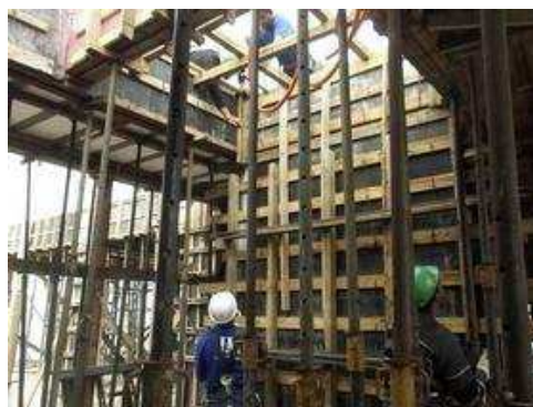
Estrutura concreto armado - 1º pavimento tipo - PILAR DO POÇO DO ELEVADOR
