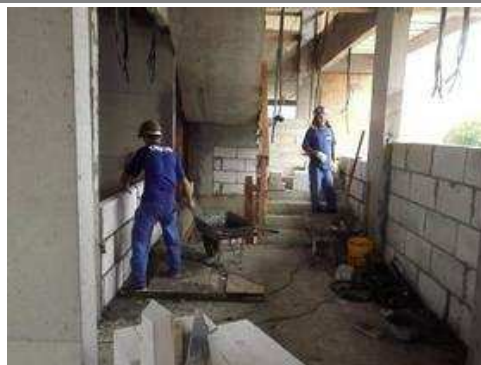
Execução da Alvenaria do 1º pavimento.
