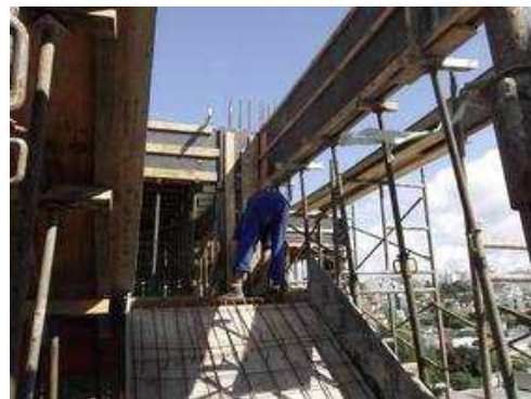
Forma de vigas, pilares - 1º pavimento tipo
