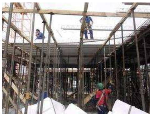
Colocação de formas e ferragem das vigas do pavimento tipo 1;
