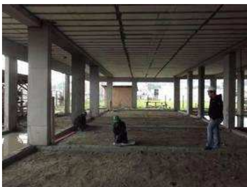
preparação piso da garagem nível térreo - compactação 22/04/2015 - Estrutura concreto armado - 1º pavimento tipo
