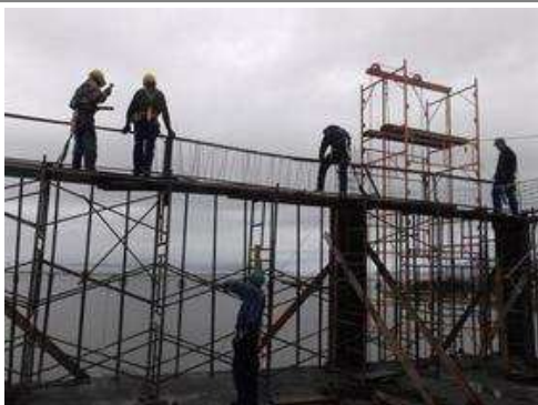
- Colocação de forma e ferragem das vigas do pavimento tipo 1 22/04/2015 - Piso térreo
