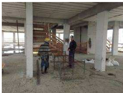
preparação piso da garagem nível térreo - compactação 22/04/2015 - Piso térreo
