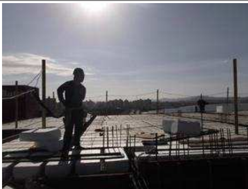
Forma de vigas, pilares e laje- 1º pavimento tipo
