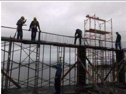
23/04/2015 - Estrutura do pavimento tipo 1
