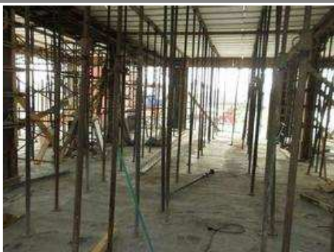
Colocação de formas e ferragem das vigas do pavimento tipo 1;
