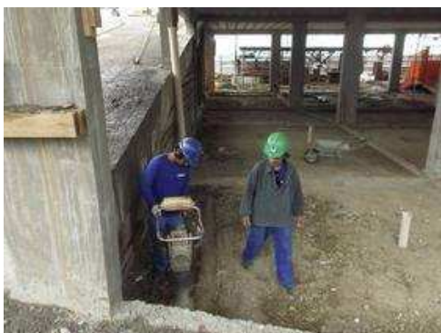
Preparação do piso térreo
