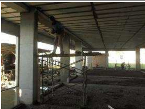
Preparação do piso térreo.
