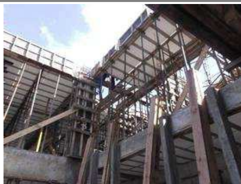
Laje 1º pavimento tipo
