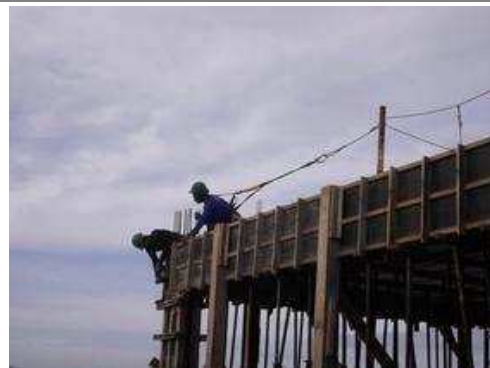
Forma de vigas, pilares - 1º pavimento tipo
