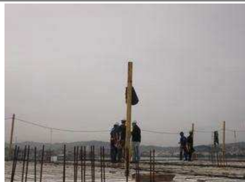
Forma das vigas externas do pavimento tipo 1;
