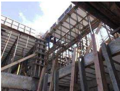
Forma de vigas, pilares e laje- 1º pavimento tipo
