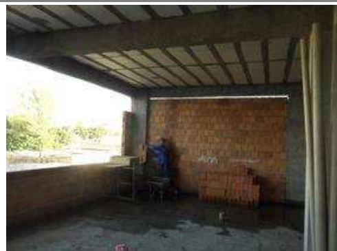
Execução de Alvenaria do 1º pavimento.
