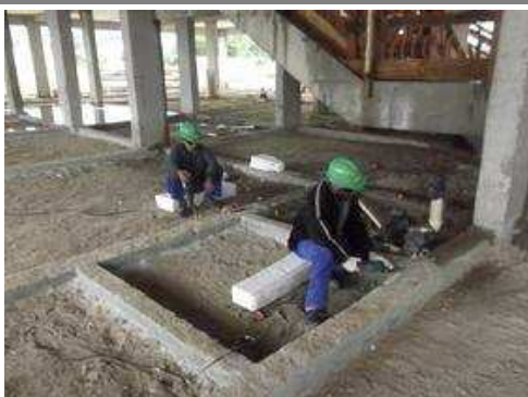
Preparação do piso térreo (compactação)
