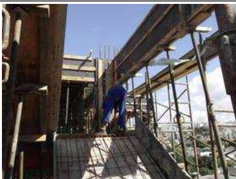
Lajes, vigas, pilares - 1º pavimento tipo
