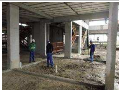
Preparação do piso térreo (compactação) 22/04/2015 - Colocação da 1ª fiada de tijos - 1º pavimento
