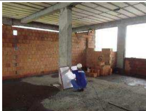
Execução de alvenaria - 1º pavimento
