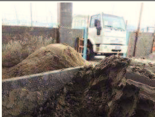
Chegada de material na obra.
