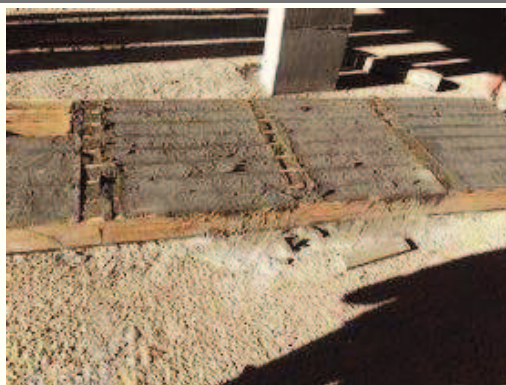
Realização das formas e colocação das ferragens do pavimento tipo 2.
