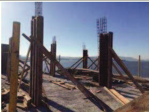
Início do fechamento das formas dos pilares do pavimento tipo 2.
