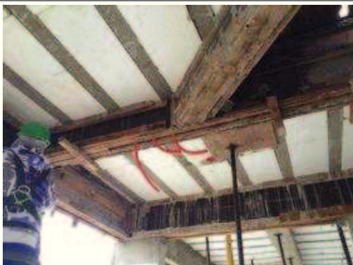
Retirada das formas do pavimento tipo 2.
