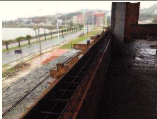
Execução do detalhe da fachada frontal
