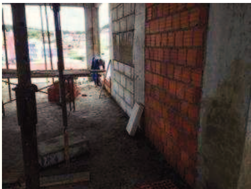
-Execução da alvenaria no 3º pavimento.
