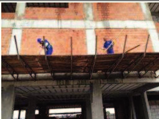
Retirada de uma parte da bandeja primária.
