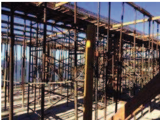
Execução da laje do pavimento tipo 2.
