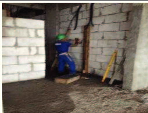
Realização da contra-verga e do shaft para futura instalação das portas de acesso a escada enclausurada.
