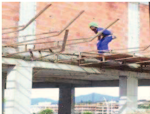
-Retirada do bandeirão nas áreas que já possuem alvenaria.
