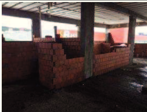
-Alvenaria do 2º pavimento.
