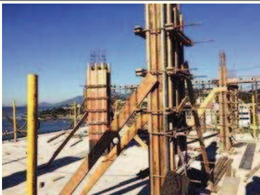
Fechamento das formas dos pilares do pavimento tipo 2.
