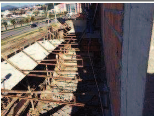
-Retirada de uma parte da bandeja do 1º pavimento.
