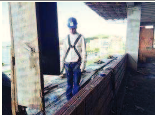
Execução das formas e ferragens do detalhe da fachada abaixo das janelas.
