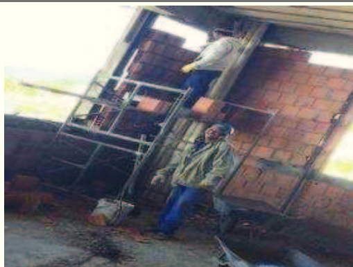
Execução da alvenaria.
