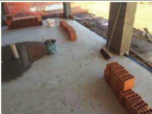
Execução da alvenaria do pavimento térreo.
