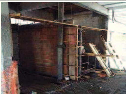
Forma das vigas e pilares entre as paredes do elevador.
