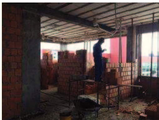
-Realização da alvenaria do 2º pavimento.
