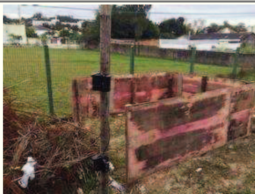
Baía para armazenamento de ferragens
