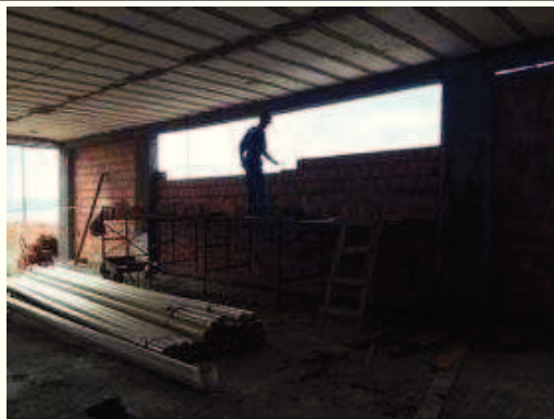
-Alvenaria do 1º pavimento.
