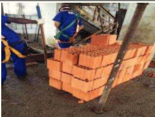
Realização da alvenaria no 3º pavimento.
