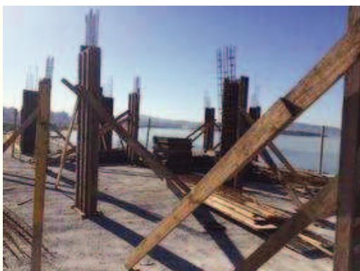
Colocação das ferragens nas formas do pavimento tipo 2.
