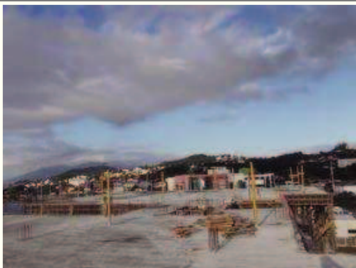
Preparação da laje térreo, colocação de armaduras de aço positivas e negativas da laje.
