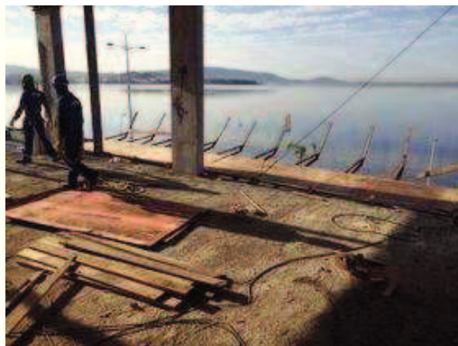
Execução da bandeja secundária.
