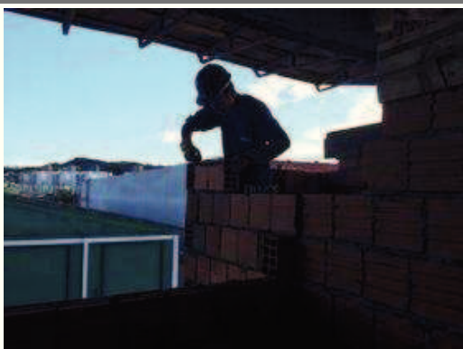
Alvenaria do 2º pavimento.
