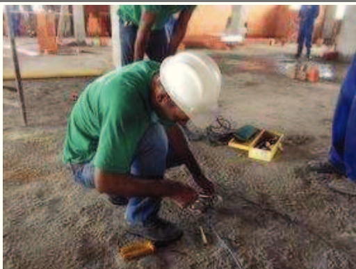
-Execução da parte elétrica provisória.
