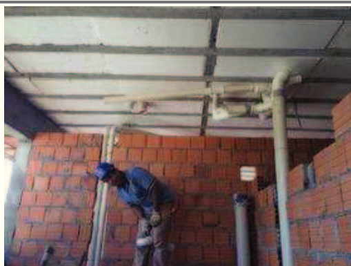
-Realização do encanamento de esgoto.
