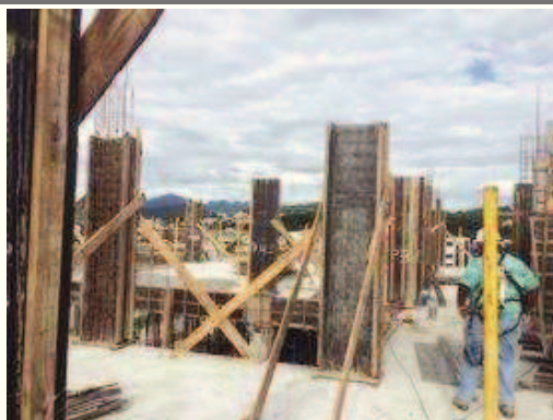
Realização das formas e colocação das ferragens do pavimento tipo 2.
