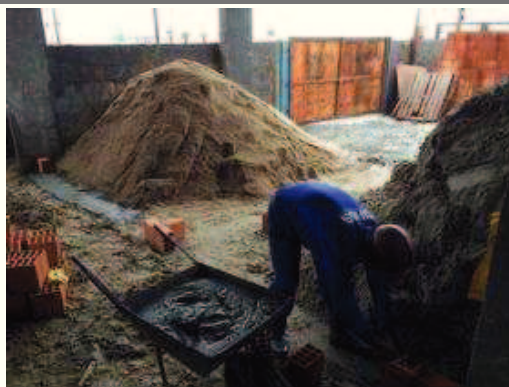
Realização das baias de argamassa e areia.
