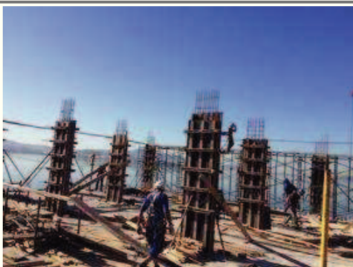
-Execução das formas das vigas do pavimento tipo 2.
