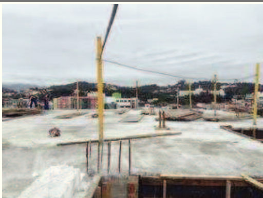
-Início da realização das formas do pavimento tipo 2;
