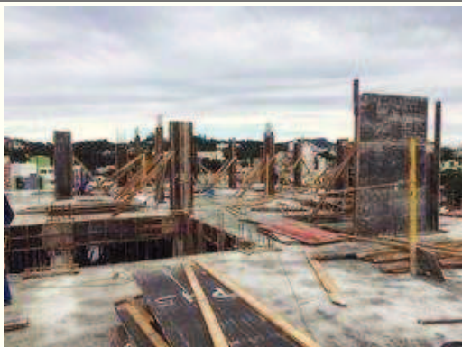
-Execução das formas para ferragens dos pilares.
