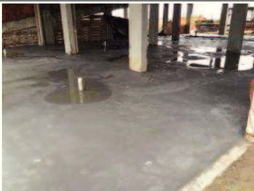
Alisamento da garagem da laje do pavimento térreo.
