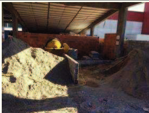
Conclusão das baias de areia e argamassa.
