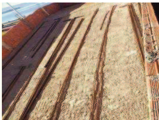
Início da separação das ferragens para montagem das vigas do pavimento tipo 2.
