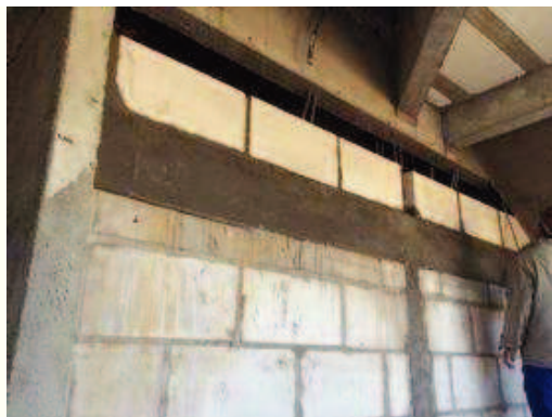
Execução da alvenaria com bloco celular nos elevadores.
