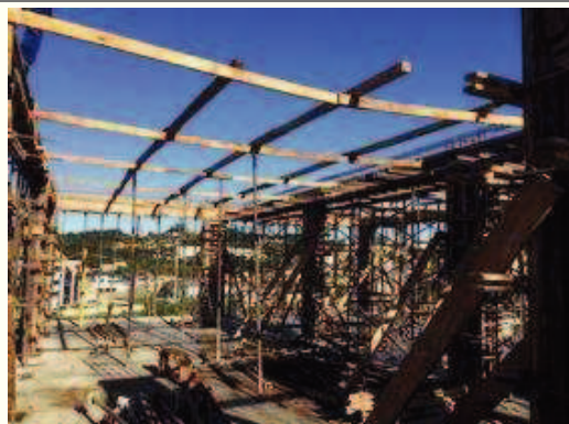
Colocação dos caibros para apoios dos vigotes.
