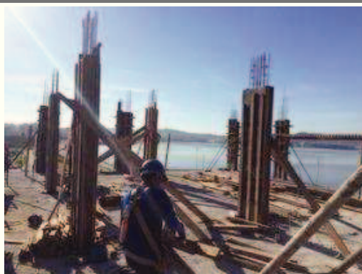
Fechamento dos pilares do pavimento tipo 2.
