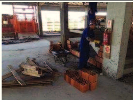
Execução da alvenaria do pavimento térreo.
