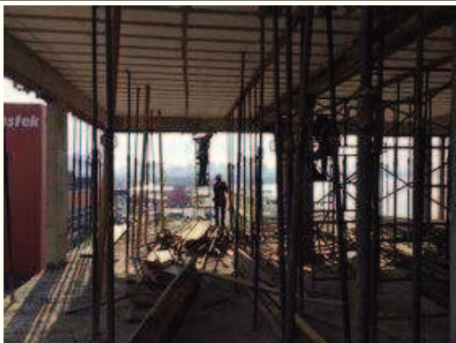
-Desforma das vigas e pilares do pavimento tipo 1.
