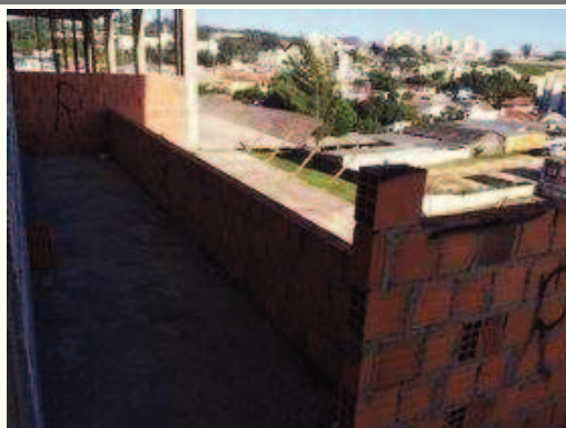
Alvenaria do 2º Pavimento.
