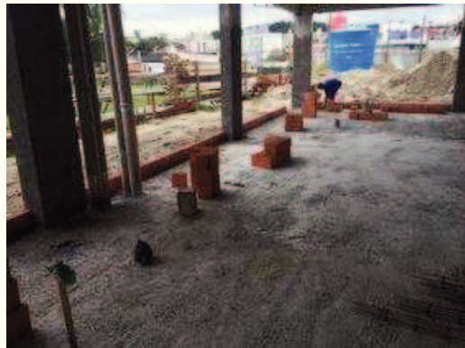
Marcação da alvenaria do pavimento térreo.
