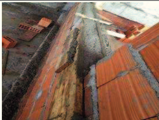
Concretagem das contra-vergas.
