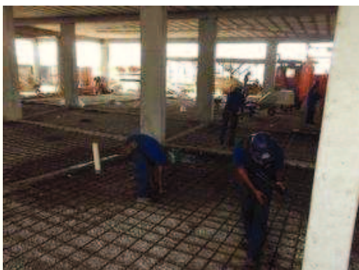
Preparação da laje térreo, colocação de armaduras de aço positivas e negativas da laje.
