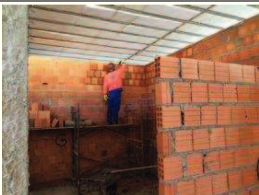
Execução da alvenaria do 2º pavimento.
