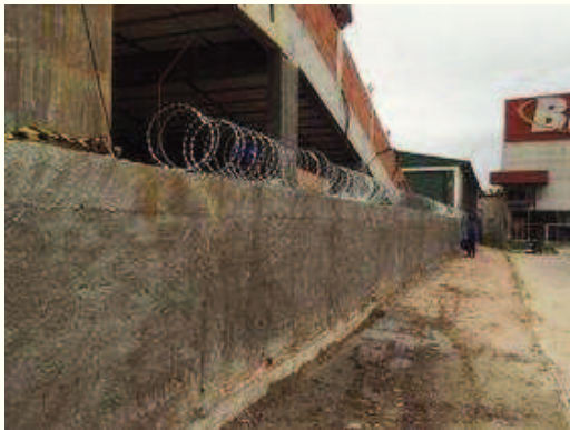
Colocação das concertinas no perímetro da obra.
