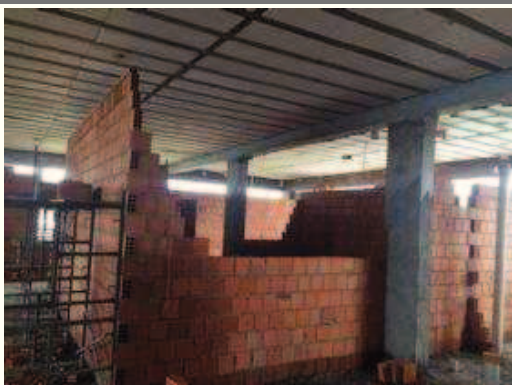
Alvenaria do 2º pavimento.
