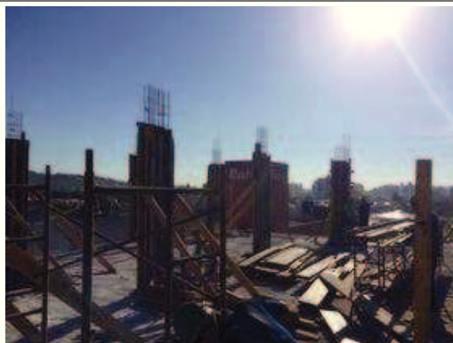
Fechamento dos pilares do pavimento tipo 2.
