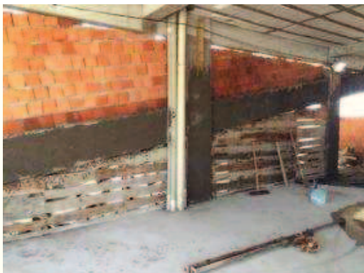
Chapiscamento da alvenaria no pavimento térreo.
