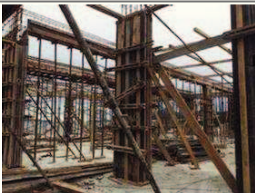
-Execução das formas das vigas do pavimento tipo 2.
