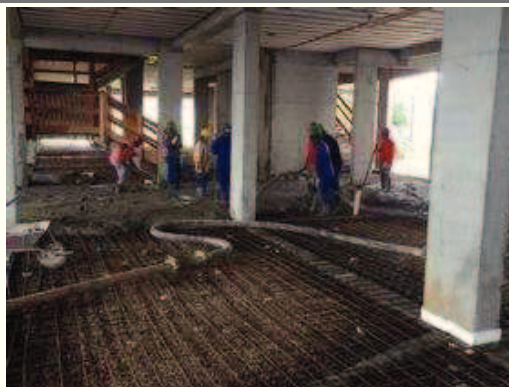
Concretagem da laje do pavimento térreo.
